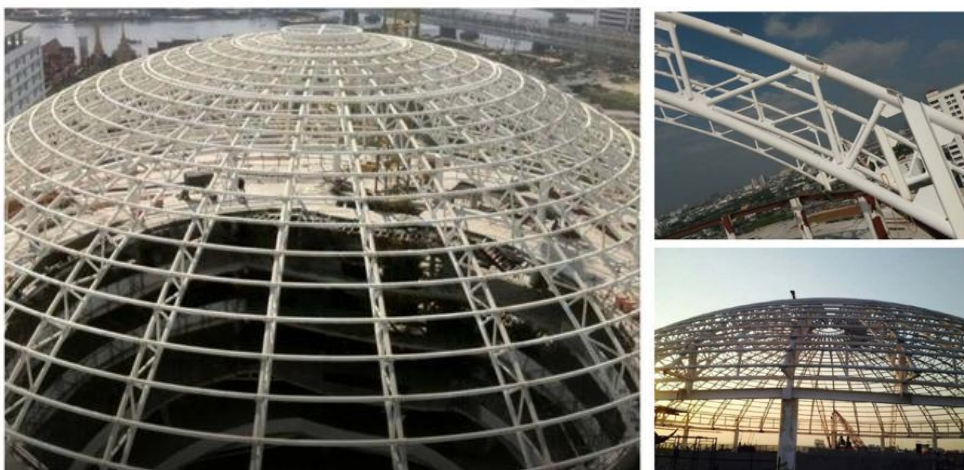
รูปภาพที่ 50 BRACED DOME STRUCTURES
