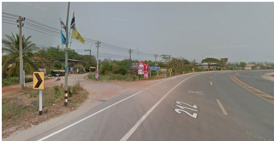
ภาพที่ 42 Approach ทางเข้า Site
