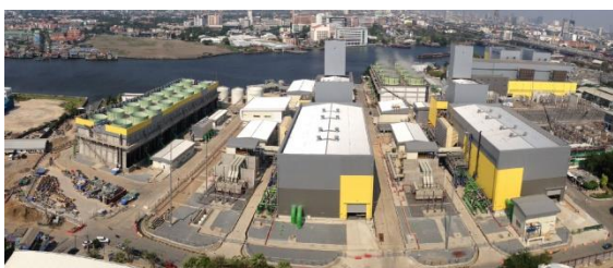
รูปที่ 2.29 พื้นที่ไม่มีมีการให้ร่มเงาจะเกิดการสะสมความร้อนและส่งผลให้อุณหภูมิสภาพแวดล้อมโดยรอบอาคารสูง (ที่มา http://www.egat.co.th/การไฟฟ้าฝ่ายผลิต , 2018)
