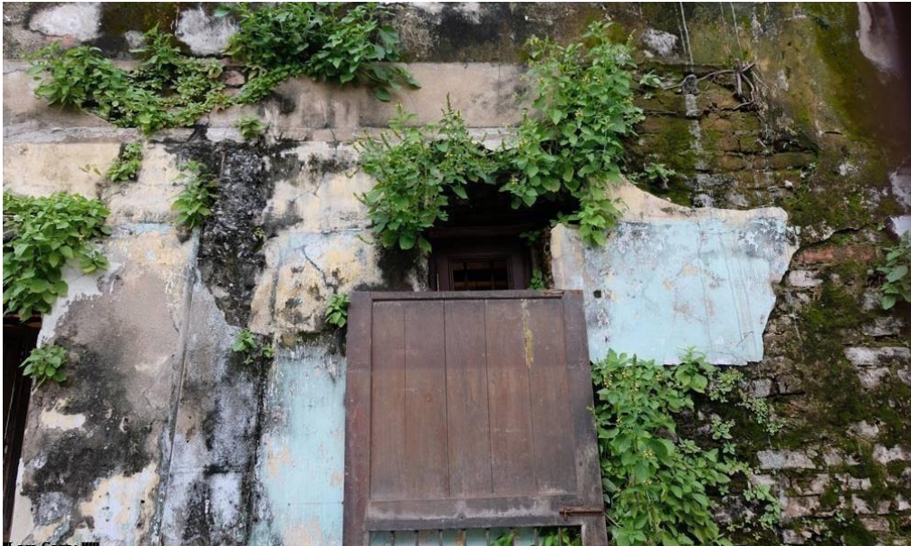
รูปที่ 14 ลิ่ง1919 กำแพงของอาคารเก่า
