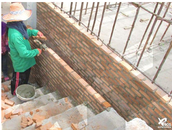
รูปที่ 6 การก่อผนังอิฐสองชั้นโดยใช้อิฐมอญ ที่มา : SCG Experience,2561
