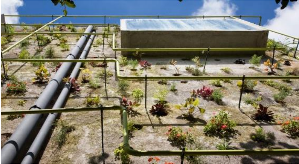
รูปที่ 16 ผนังคอนกรีตมีชีวิต (Organic Concrete)
