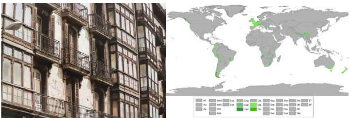
ภาพที่ 9 แสดงลักษณะการสร้างอาคารที่มีช่องหน้าต่างจำนวนมากเพื่อรับแสงสว่าง(สุทศน์ เขียมวัฒนา,ลักษณะสถาปัตยกรรมในภูมิภาคเขตต่างๆของโลก,หน้า11)
