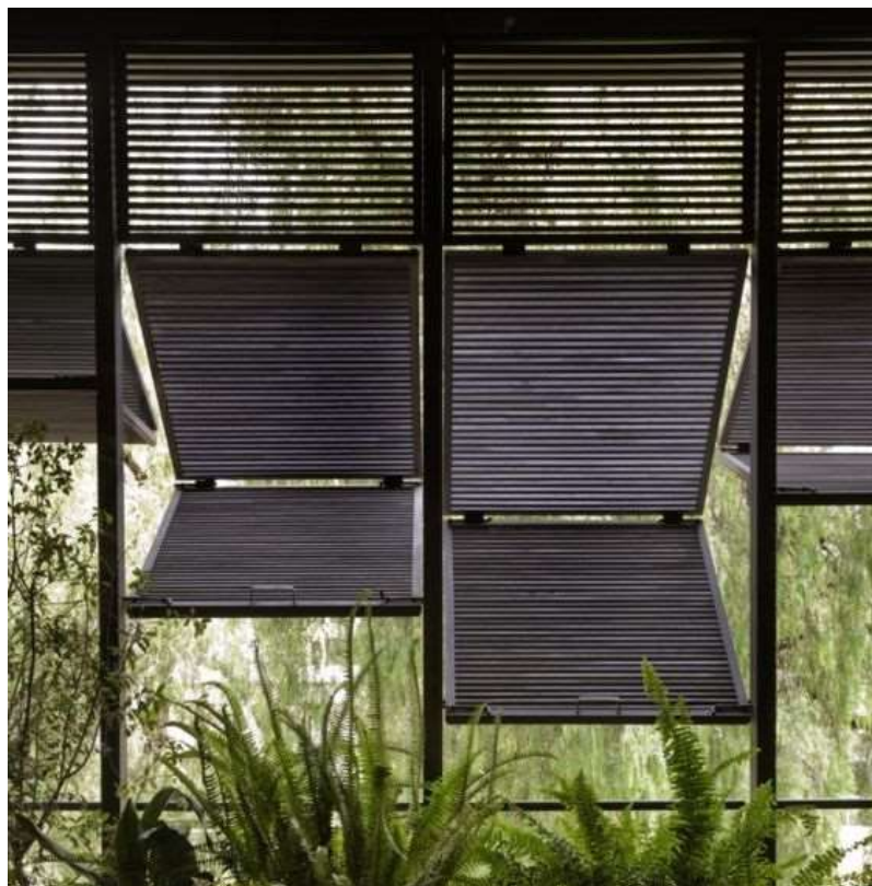
ภาพที่ 20 แสดงลักษณะช่องเปิดระแนงไม้ที่สามารถระบายอากาศได้ ที่มา https://dsignsomething.com/2016/04/02/modern-tropical-ร่วมสมัยสไตล์เขตร้อน/
