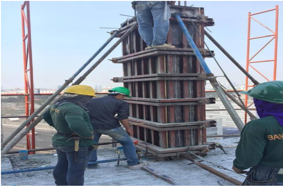
รูปที่ ค 7 แสดงการทำงานกิจกรรมงานเซ็คตั้งเสา
