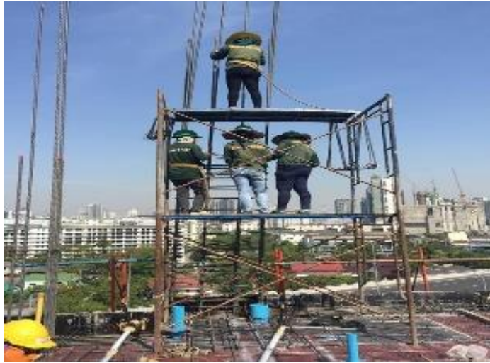
รูปที่ 3.3 กิจกรรมงานเหล็กเสริม
