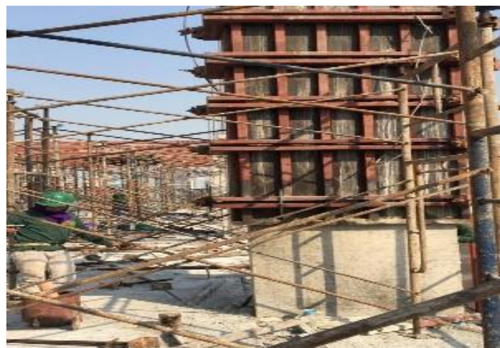
รูปที่ 3.6 กิจกรรมงานถอดไม้แบบเสา
