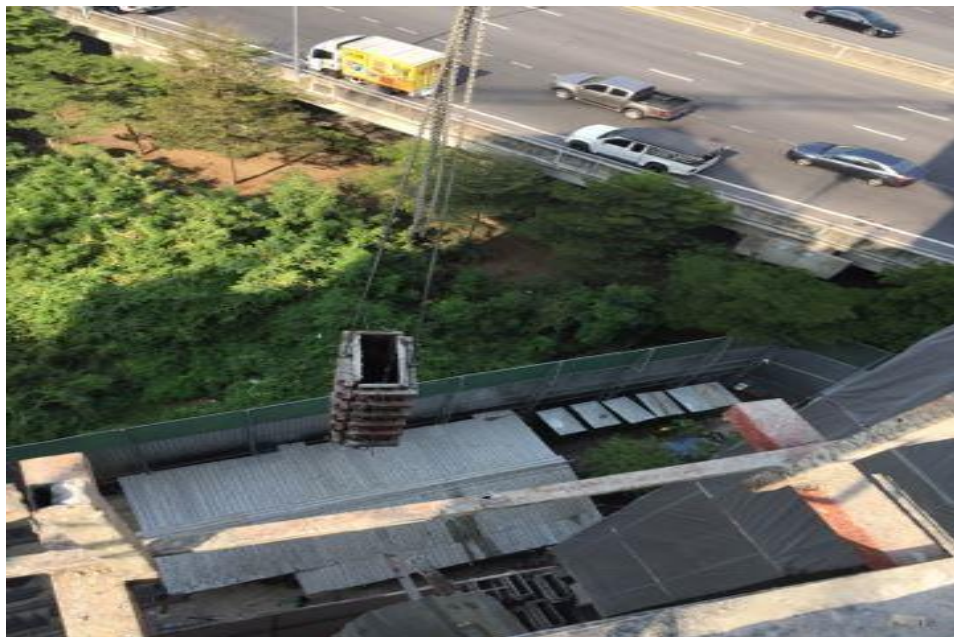
รูปที่ ค 10 แสดงการทำงานกิจกรรมงานตั้งไม้แบบเสานำลงชั้นล่าง
