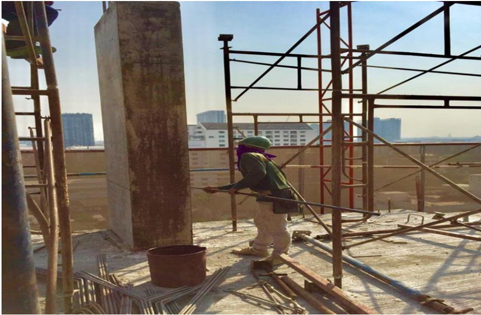
รูปที่ ค 11 แสดงการทำงานกิจกรรมงานทาน้ำยาบ่มคอนกรีต
