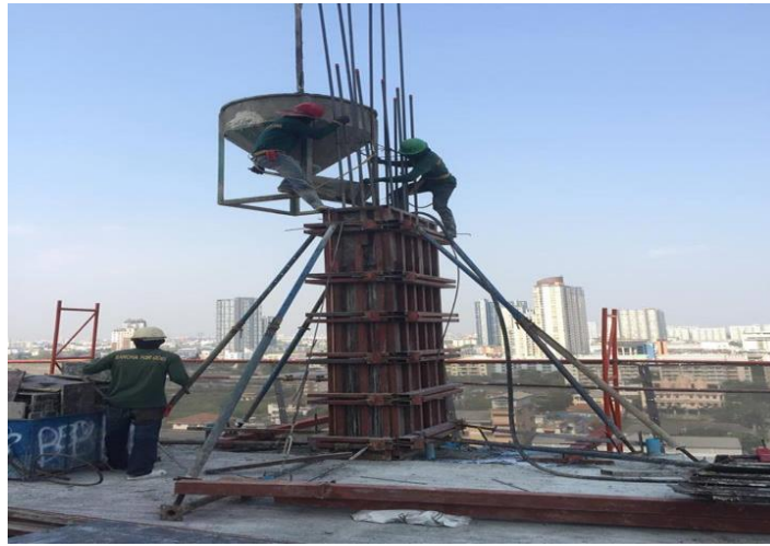
รูปที่ 3.5 กิจกรรมงานเทคอนกรีต
