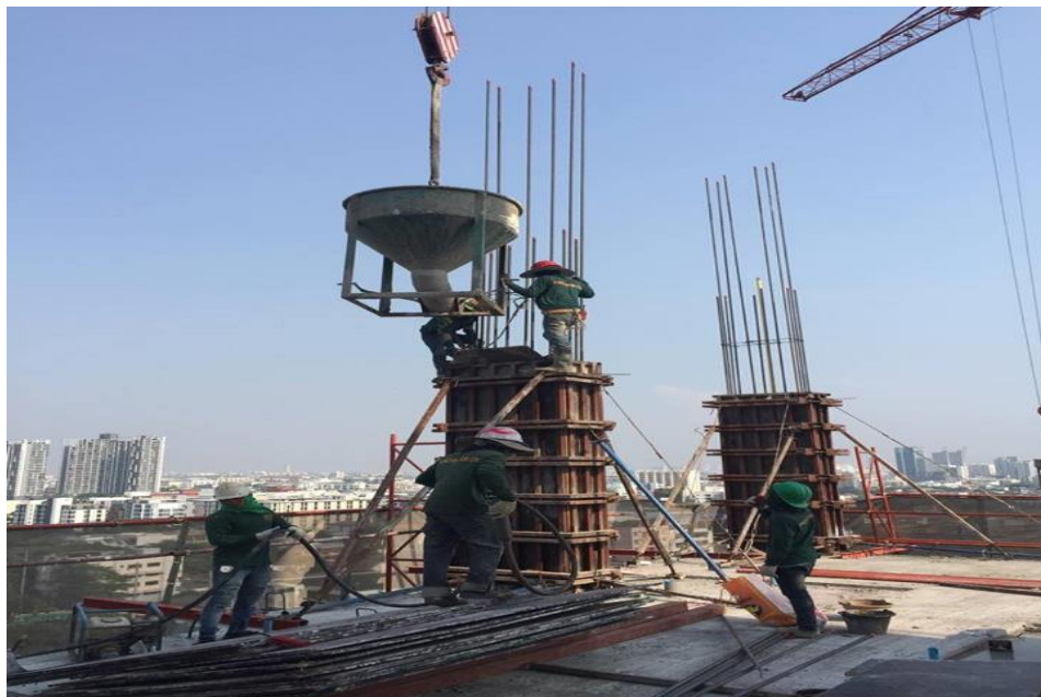
รูปที่ ค 8 แสดงการทำงานกิจกรรมงานเทคอนกรีต+จัดคอนกรีต
