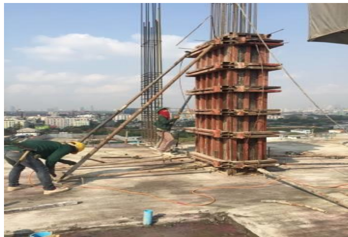
รูปที่ 3.4 กิจกรรมงานเข้าแบบเสา
