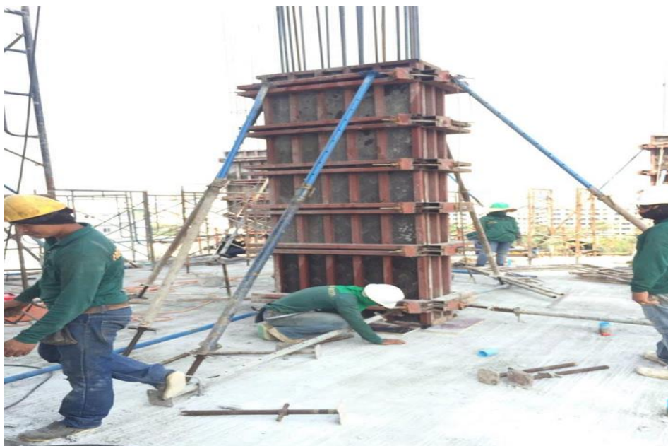
รูปที่ ค 6 แสดงการทำงานกิจกรรมงานเข้าแบบเสา
