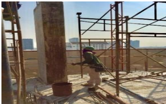
รูปที่ 3.7 กิจกรรมงานทาน้ำยาบ่มคอนกรีตเสา
