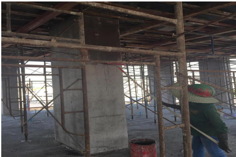
รูปที่ ค 12 แสดงการทำงานกิจกรรมงานทาน้ำยาบ่มคอนกรีต
