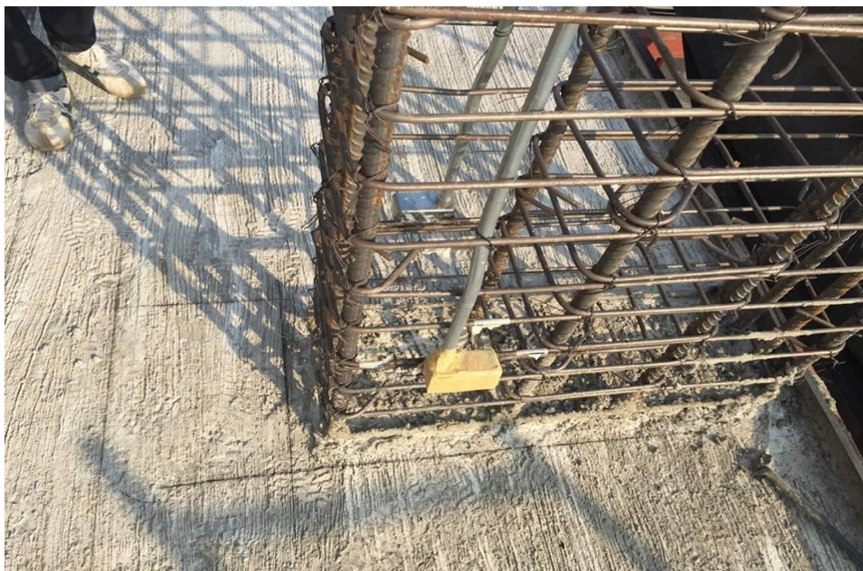
รูปที่ ค 4 แสดงการทำงานกิจกรรมงานตีไลน์เสาะ
