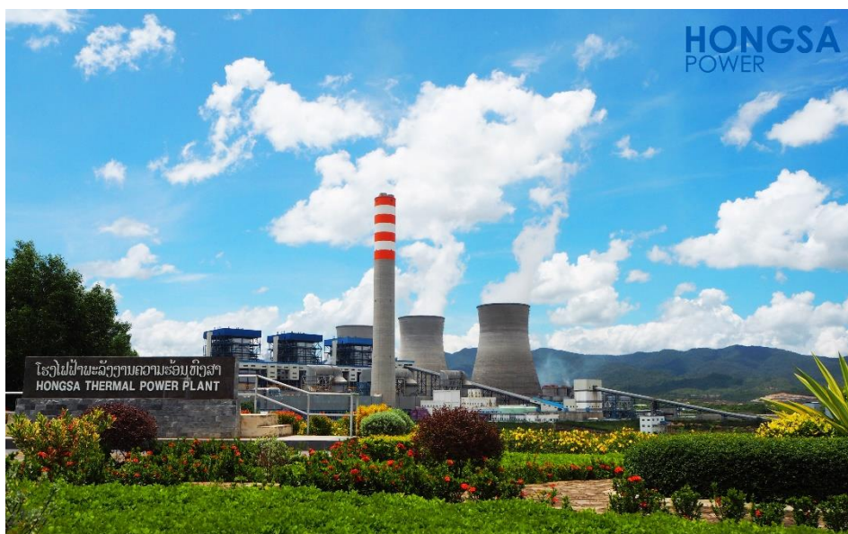
ภาพประกอบที่ 1.1 โรงไฟฟ้าถ่านหินที่เมืองหงสา แขวงไซยะบูลี สปป. ลาว (บริษัทไฟฟ้าหงสา จำกัด, 2561)
