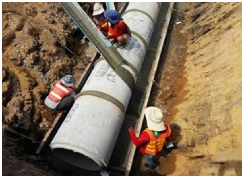
รูปที่ ค.8 ทำการเทบล็อกท่อเพื่อไม่ให้ท่อระบายน้ำขยับหรือแยกออกจากกัน
