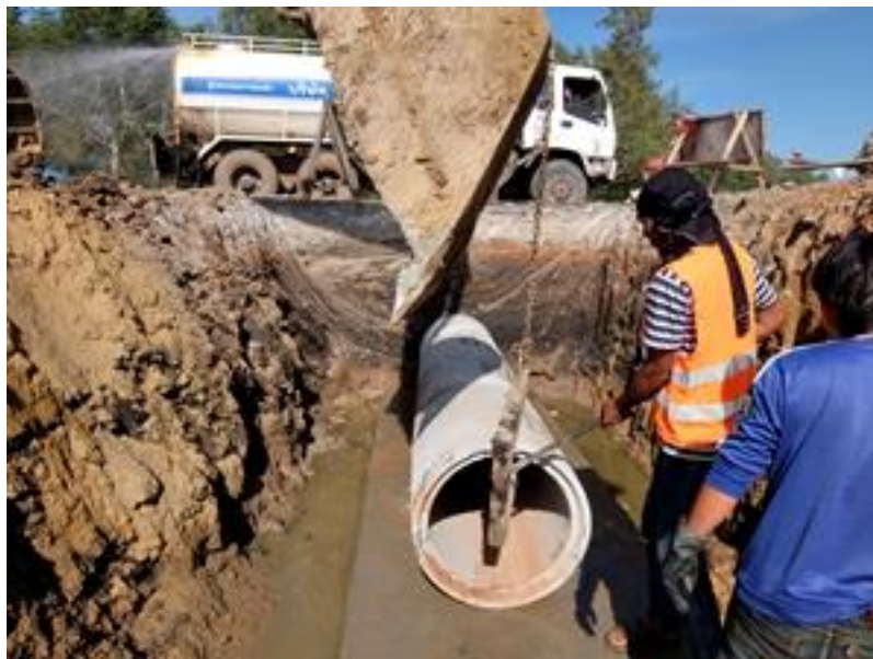
รูปที่ ค.6 ใช้ตะขอเกี่ยวกับท่อระบายน้ำแล้วยกไปวางประกอบเข้าด้วยกันโดยจะต้องใช้ความระมัดระวังในขั้นตอนนี้
