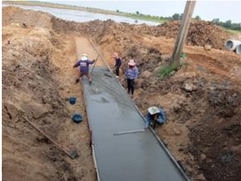
รูปที่ ค.5 ทำการเทคอนกรีตลงไปแบบที่เตรียมเอาไว้
