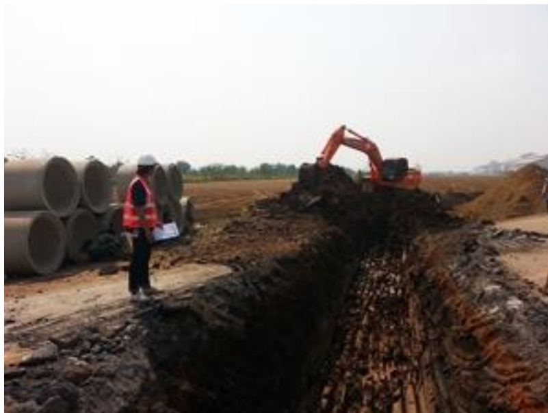
รูปที่ ค.2 การขุดเปิดหน้าผิวถนนเพื่อขุดหลุมในการวางท่อระบายน้ำ
