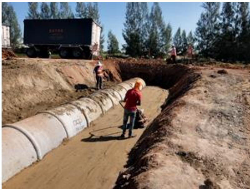
รูปที่ ค. 9 นำทรายมาถมหลังท่อระบายน้ำ
