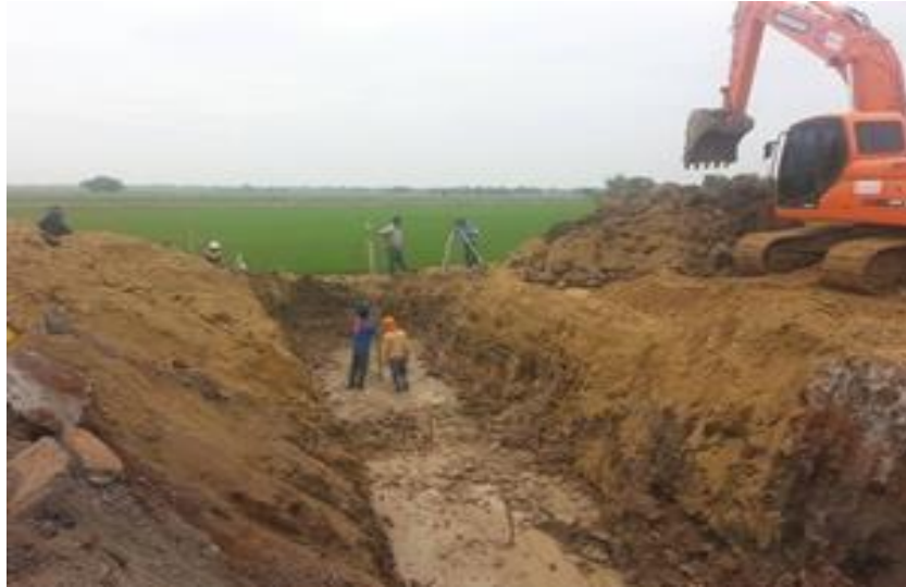
รูปที่ ค.3 การวัดระดับความลึกตามแบบที่วางไว้
