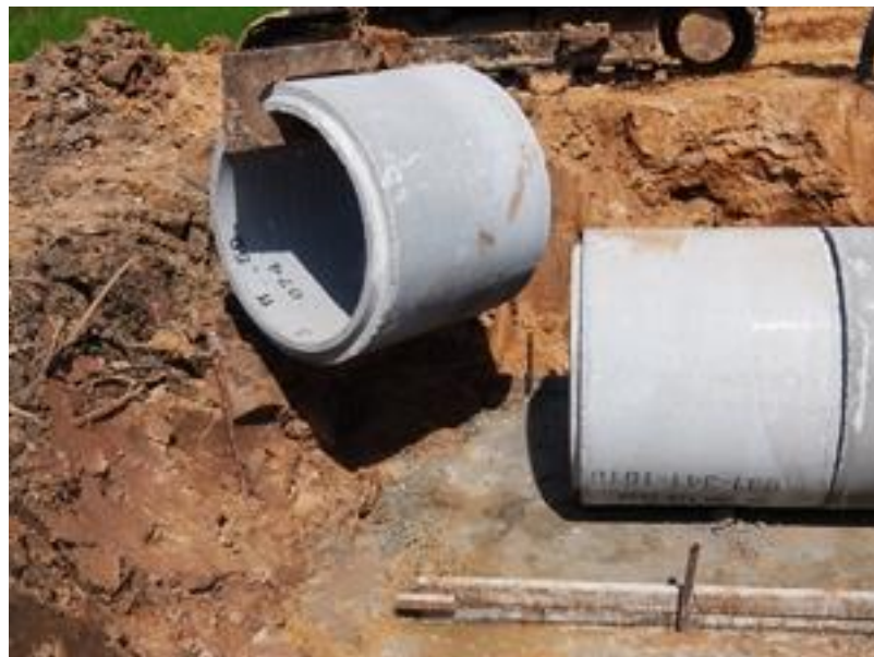
รูปที่ ค.6 ใช้ตะขอเกี่ยวกับท่อระบายน้ำแล้วยกไปวางประกอบเข้าด้วยกันโดยจะต้องใช้ความระมัดระวังในขั้นตอนนี้
