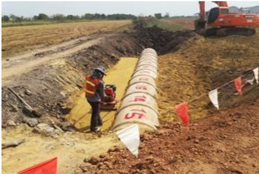
รูปที่ ค.9 นำทรายมาถมหลังท่อระบายน้ำ
