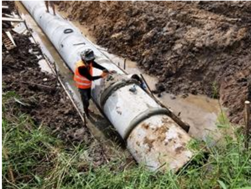
รูปที่ ค.7 ปิดรอยต่อท่อทั้งด้านนอกท่อและภายในท่อระบายน้ำ
