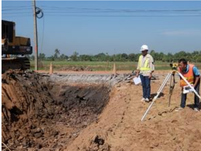
รูปที่ ค.3 การวัดระดับความลึกตามแบบที่วางไว้
