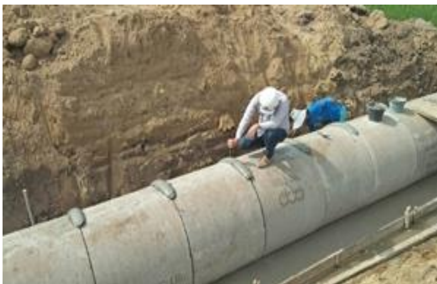
รูปที่ ค.7 ปิดรอยต่อท่อทั้งด้านนอกท่อและภายในท่อระบายน้ำ
