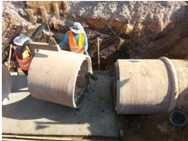
รูปที่ ค.6 ใช้ตะขอเกี่ยวกับท่อระบายน้ำแล้วยกไปวางประกอบเข้าด้วยกันโดยจะต้องใช้ความระมัดระวังในขั้นตอนนี้
