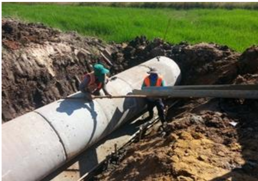
รูปที่ ค.8 ทำการเคลื่อนท่อเพื่อไม่ให้ท่อระบายน้ำขยับหรือแยกออกจากกัน
