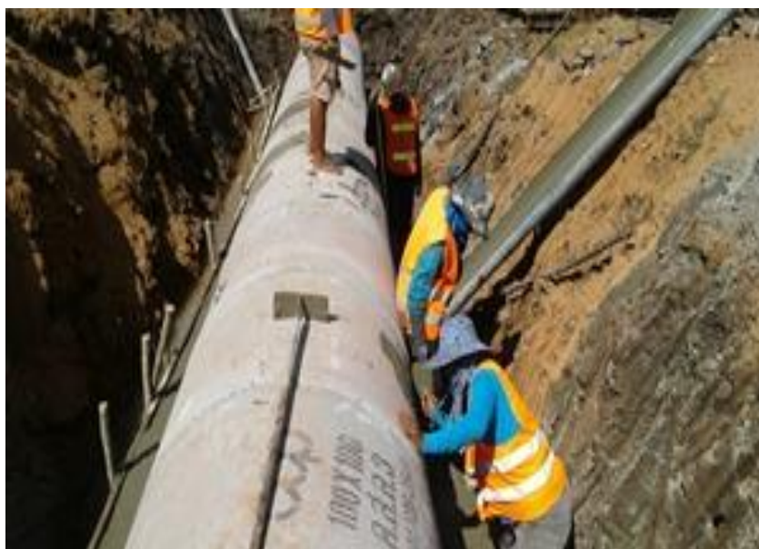
รูปที่ ค.8 ทำการเหล็กรอกท่อเพื่อไม่ให้ท่อระบายน้ำขยับหรือแยกออกจากกัน
