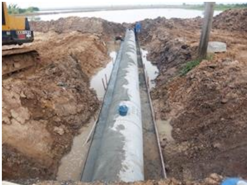
รูปที่ ค.6 ใช้ตะขอเกี่ยวกับท่อระบายน้ำแล้วยกไปวางประกอบเข้าด้วยกันโดยจะต้องใช้ความระมัดระวังในขั้นตอนนี้
