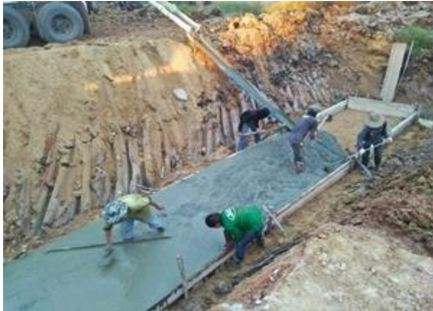
รูปที่ ค.5 ทำการเทคอนกรีตลงไปแบบที่เตรียมเอาไว้
