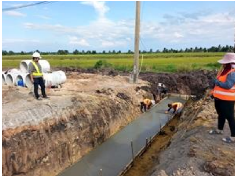
รูปที่ ค.5 ทำการเทคอนกรีตลงไปแบบที่เตรียมเอาไว้
