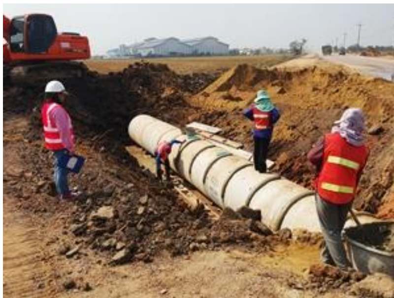
รูปที่ ค.7 ปิดรอยต่อท่อทั้งด้านนอกท่อและภายในท่อระบายน้ำ
