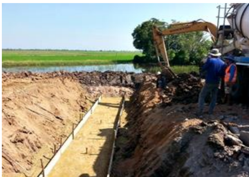
รูปที่ ค.4 การเตรียมไม้แบบและการติดตั้งไม้แบบเพื่อจะทำการเทคอนกรีต
