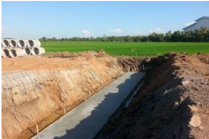
รูปที่ ค.5 ทำการเทคอนกรีตลงไปแบบที่เตรียมเอาไว้
