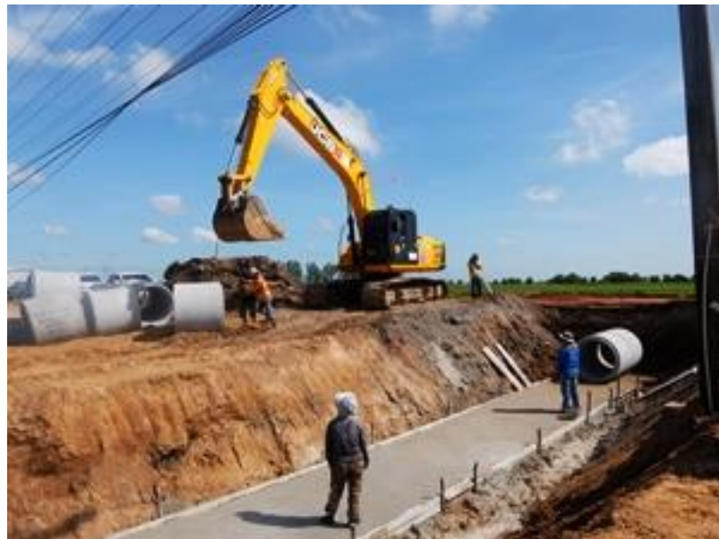
รูปที่ ค.6 ใช้ตะขอเกี่ยวกับท่อระบายน้ำแล้วยกไปวางประกอบเข้าด้วยกันโดยจะต้องใช้ความระมัดระวังในขั้นตอนนี้
