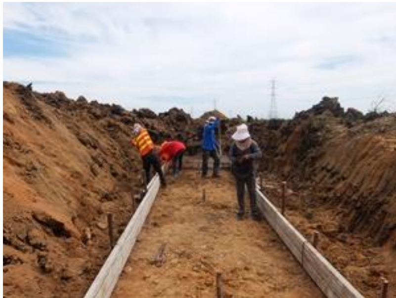
รูปที่ ค.4 การเตรียมไม้แบบและการติดตั้งไม้แบบเพื่อจะทำการเทคอนกรีต
