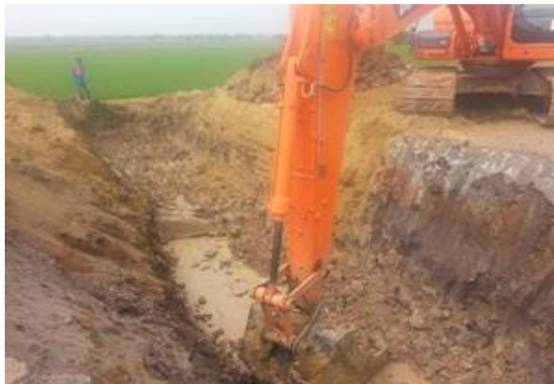
รูปที่ ค.2 การขุดเปิดหน้าผิวถนนเพื่อขุดหลุมในการวางท่อระบายน้ำ
