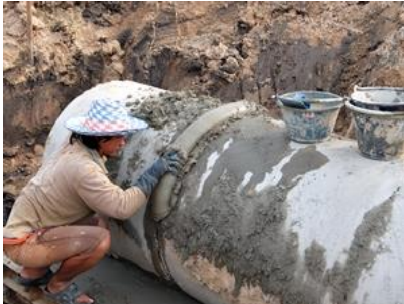
รูปที่ ค.7 ปิดรอยต่อท่อทั้งด้านนอกท่อและภายในท่อระบายน้ำ
