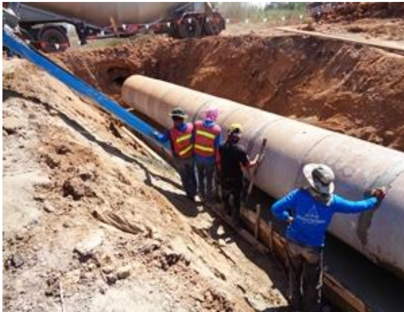
รูปที่ ค.8 ทำการเคลื่อนท่อเพื่อไม่ให้ท่อระบายน้ำขยับหรือแยกออกจากกัน
