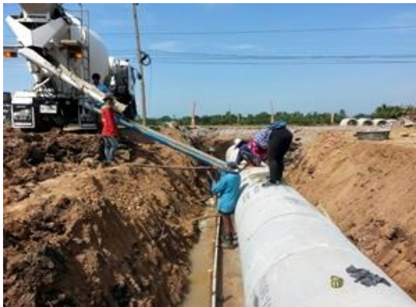
รูปที่ ค.8 ทำการเคลื่อนท่อเพื่อไม่ให้ท่อระบายน้ำขยับหรือแยกออกจากกัน
