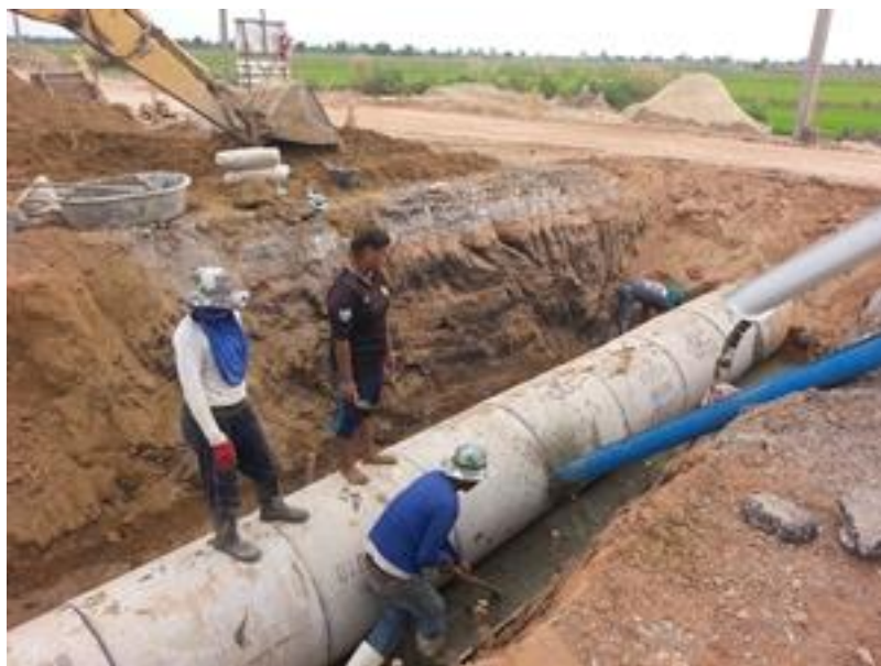
รูปที่ ค.8 ทำการเหลื่อมท่อเพื่อไม่ให้ท่อระบายน้ำขยับหรือแยกออกจากกัน
