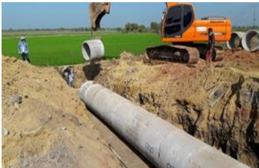
รูปที่ ค.6 ใช้ตะขอเกี่ยวกับท่อระบายน้ำแล้วยกไปวางประกอบเข้าด้วยกันโดยจะต้องใช้ความระมัดระวังในขั้นตอนนี้
