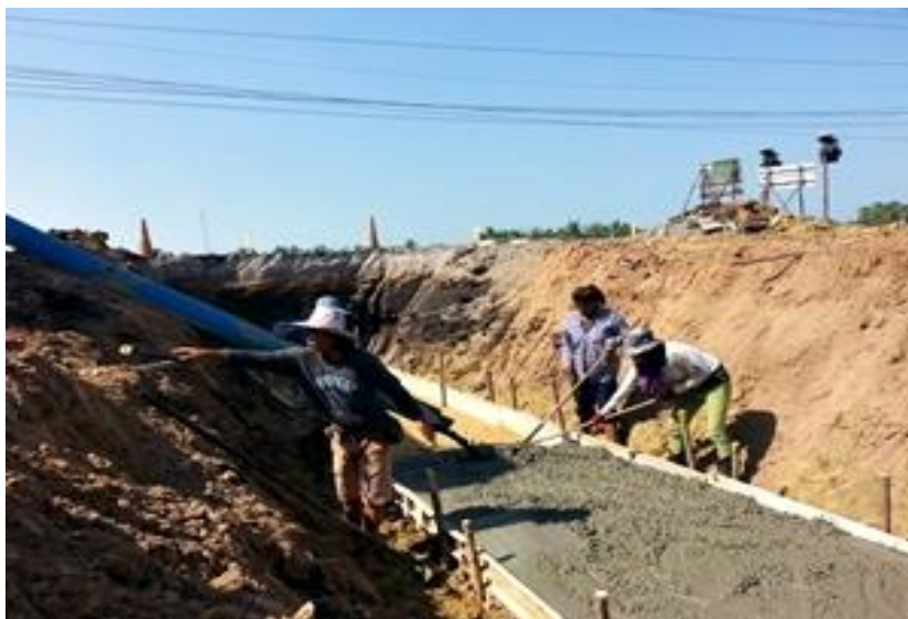
รูปที่ ค.5 ทำการเทคอนกรีตลงไปในรูปแบบที่เตรียมเอาไว้
