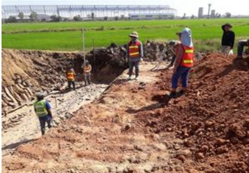
รูปที่ ค.3 การวัดระดับความลึกตามแบบที่วางไว้
