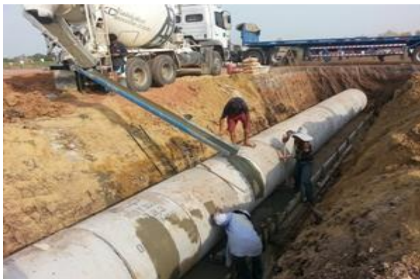
รูปที่ ค.8 ทำการเคลือบท่อเพื่อไม่ให้ท่อระบายน้ำขยับหรือแยกออกจากกัน
