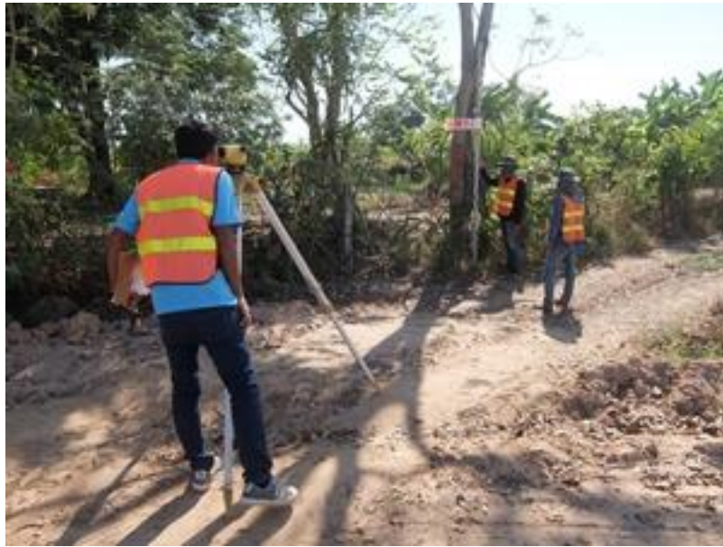
รูปที่ ค.1 การวางระดับเพื่อวางแนวขุด
