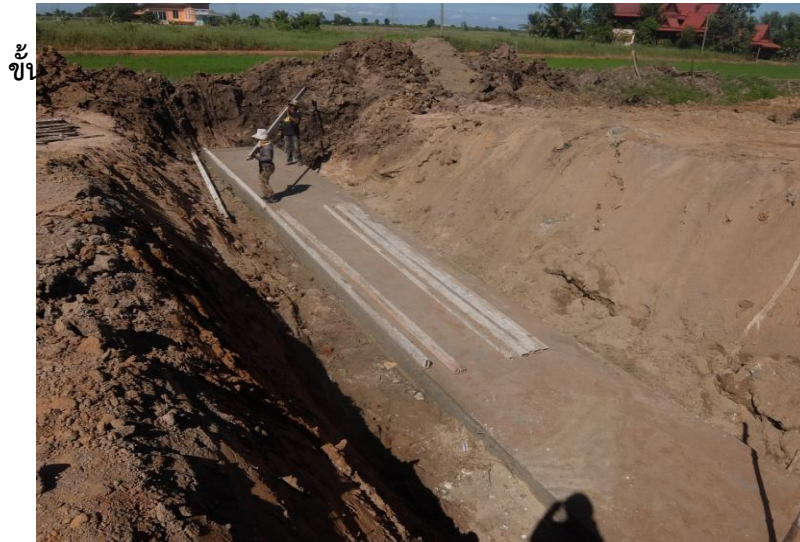
รูปที่ 3.13 รูปแสดงการรื้อถอนไม้แบบ
