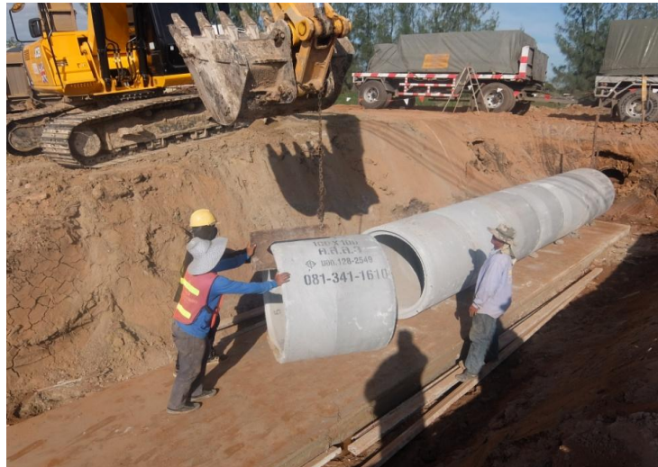
รูปที่ 3.3 รูปแสดงการติดตั้งท่อระบายน้ำคอนกรีตเสริมเหล็ก
