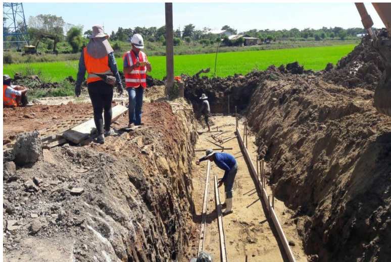
รูปที่ 3.9 รูปแสดงเตรียมไม้แบบและการติดตั้งไม้แบบ
