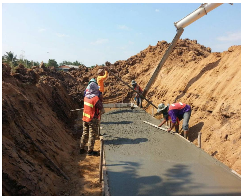
รูปที่ 3.12 รูปแสดงการทำกรเทคอนกรีต
