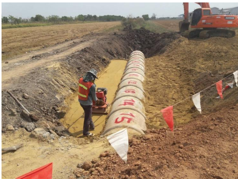
รูปที่ 3.17 แสดงการนำทรายมาถมหลังท่อระบายน้ำ
