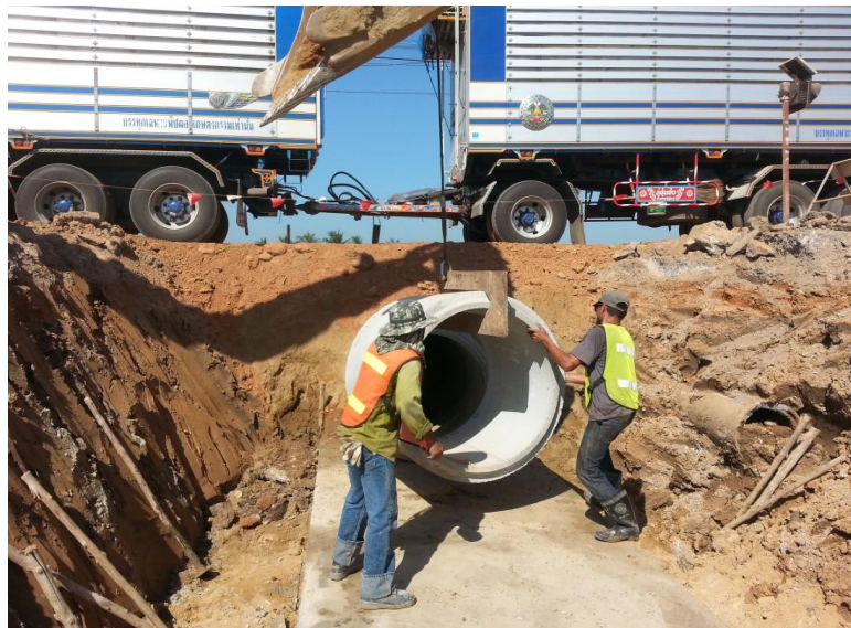
รูปที่ 3.14 รูปแสดงการใช้ตะขอเกี่ยวกับท่อระบายน้ำ
