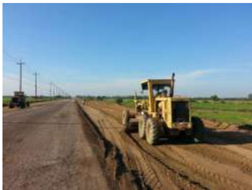
งาน Mixed Process ทรายถมคันทาง กม. 20+000 – 20+200 RT
