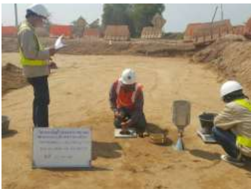
งาน Field Density Test ทรายถมหลังท่อลอดเหลี่ยม ค.ส.ล. กม. 24+182 LT
