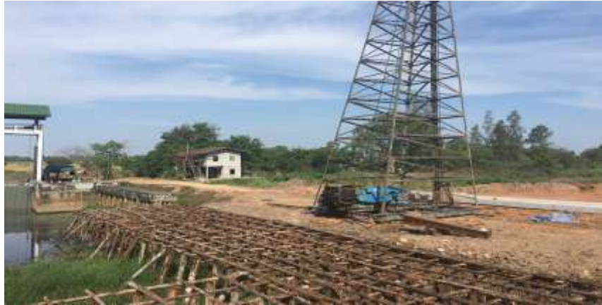
รูปที่ 3.10 ขั้นตอนตอกเสาเข็มคอนกรีตอัดแรงสะพาน : คนงานมีไม่เพียงพอต่อหน้างาน
