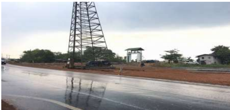
รูปที่ 3.11 ขั้นตอนตอกเสาเข็มคอนกรีตอัดแรงสะพาน : ฝนตกหนักทำให้ไม่สามารถทำงานได้
