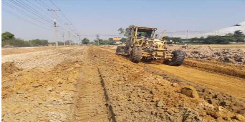
รูปที่ 3.8 ขั้นตอนการMixed Process ทราয়ถมคันทาง : เครื่องจักรไม่เพียงพอ
