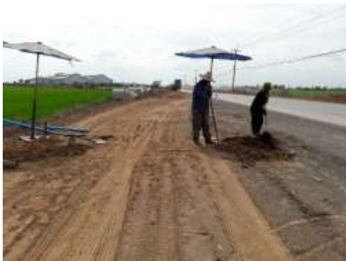
งานติดตั้ง Settlement Plate กม. 23+400 LT
