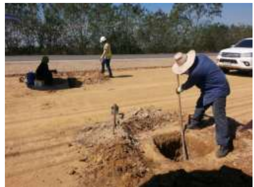
งานติดตั้ง Settlement Plate กม. 17+200 LT,RT
