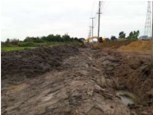
งานกรุยแนวทางและขุดตอ กม. 11+700 – 11+800 LT
