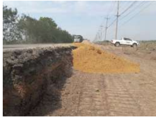
งานลงวัสดุทรายถมคันทาง กม. 11+100 – 11+300 LT
