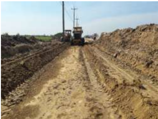
งาน Mixed Process ทรายถมคันทาง กม. 20+640 – 20+700 LT,RT
