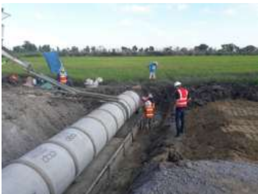
งานท่อระบายน้ำ ค.ส.ล. ท่อ 1- \phi 0.80 ม. กม. 23+603 LT
