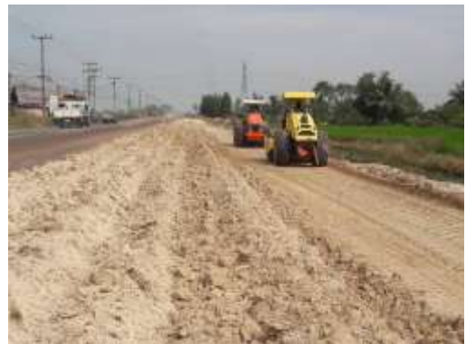
งาน Mixed Process ทรายถมคันทาง กม. 28+500 – 28+800 LT,RT
