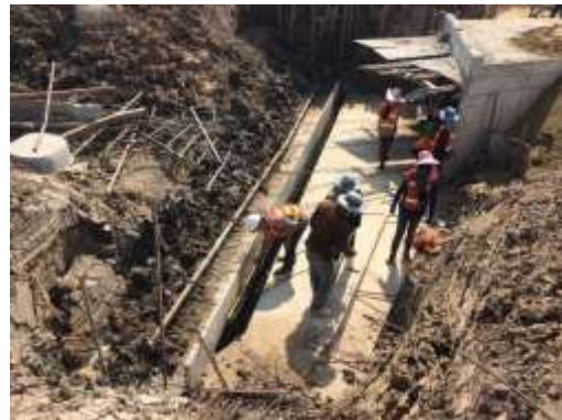
งานผูกเหล็กพื้นท่อลอดเหลี่ยม ค.ส.ล. กม. 24+182 LT
