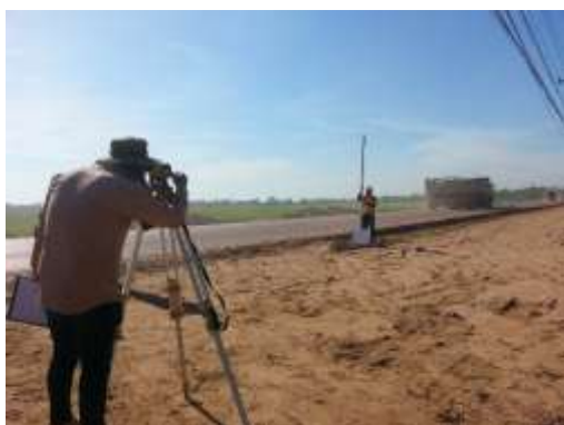
งานตรวจสอบค่าการทรุดตัวของทรายถมคันทาง กม. 22+000 – 22+800 LT,RT
