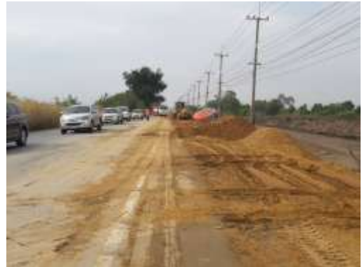
งานลงวัสดุทรายถมคันทาง กม. 13+300 – 13+500 LT
