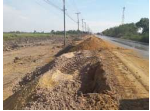
งานลงวัสดุทรายถมคันทาง กม. 11+300 – 11+500 LT
