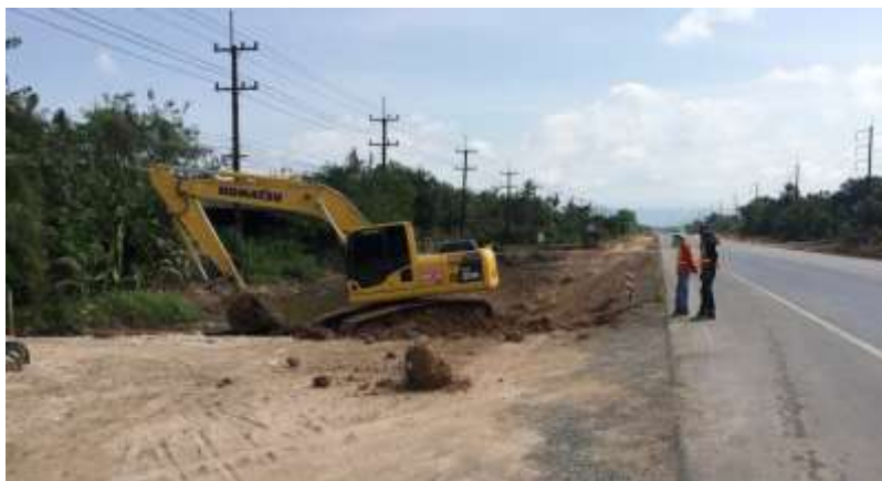
รูปที่ 3.6 ขั้นตอนเคลียพื้นที่ก่อสร้างถนน : เครื่องจักรมีปัญหา
