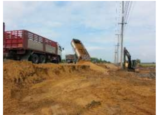
งานลงวัสดุทรายถมคันทาง กม. 11+700 – 11+900 LT
