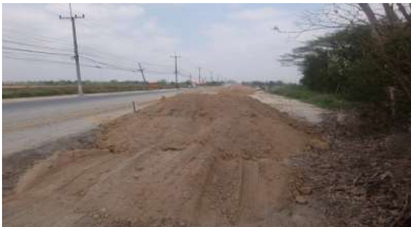
รูปที่ 2.3 ผู้รับเหมาลงวัสดุประเภททราย แต่ไม่มีเครื่องจักรมาปรับเกรดทราคมคันทาง
