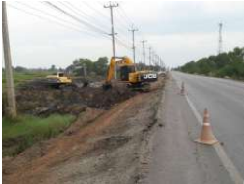
งานกรุยแนวทางและขุดตอ กม. 11+300 – 11+600 LT
