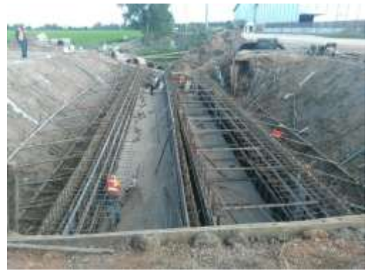
งานเข้าแบบผนังท่อลอดเหลี่ยม ค.ส.ล. กม. 24+182 LT
