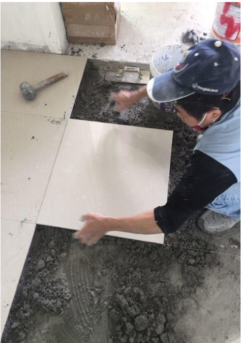
รูปที่ ก 7 ปูกระเบื้องพื้นครัว
