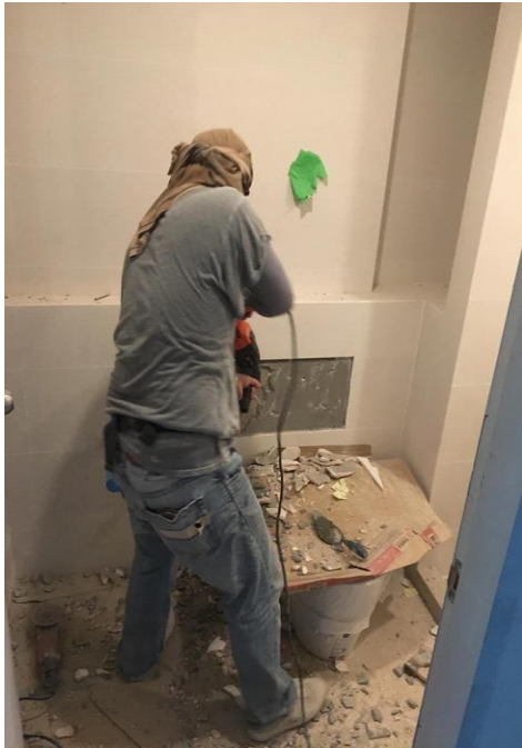
รูปที่ ก 9 การสกัดกระเบื้องที่ไม่ผ่านทิ้งไป
