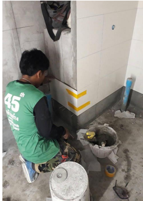
รูปที่ ก 6 ปูกระเบื้องผนังห้องน้ำ
