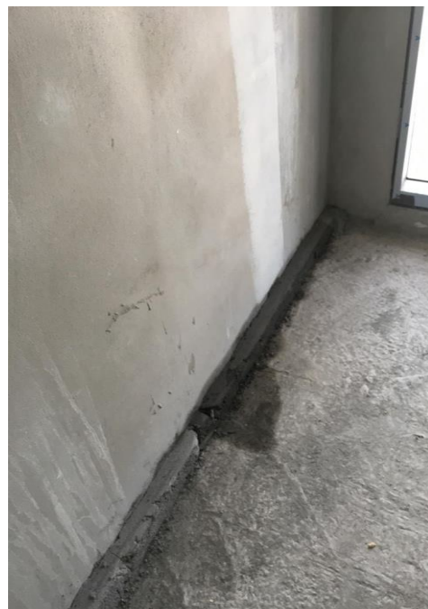
รูปที่ ก 12 กันซึมรั่วออกมาตรงทางเดิน
