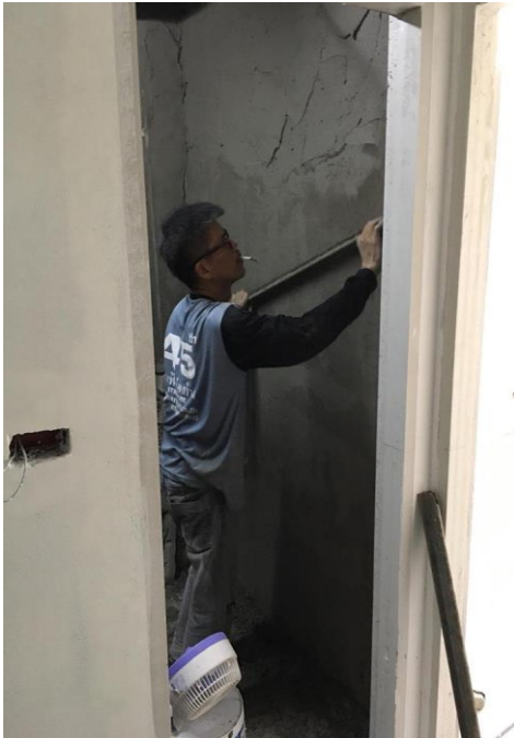
รูปที่ ก 1 จับเชื่อม+ฉาบ ผนังห้องน้ำ
