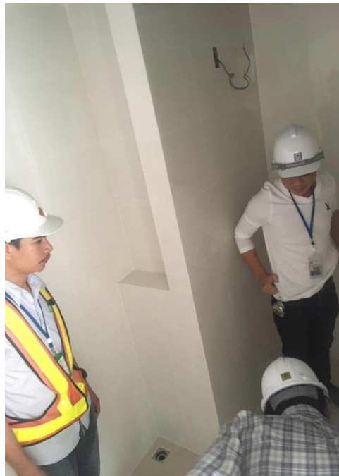
รูปที่ ก 8 ตรวจสอบ Defect กระเบื้อง
