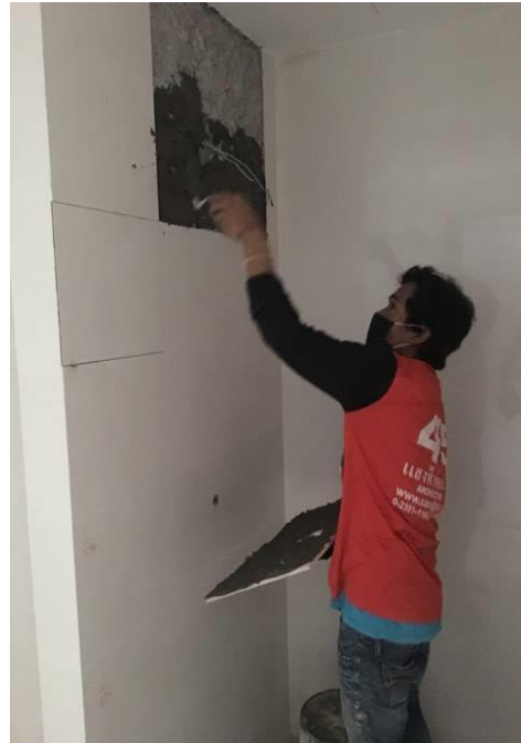
รูปที่ ก 10 การแก้ไขกระเบื้องโดยใส่แผ่นใหม่
