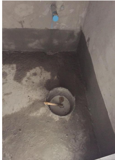
รูปที่ ก 2 ทากันซึม
