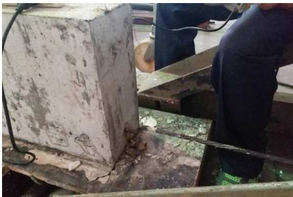
รูปที่ 3.1.16 การตัดลวดอัดแรง
