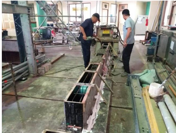
รูปที่ 3.1.18 การจี้คอนกรีตระหว่างหล่อคาน
