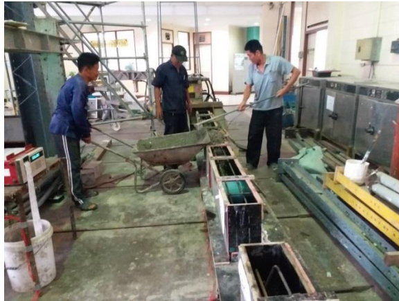
รูปที่ 3.1.10 การขนย้ายคอนกรีต
