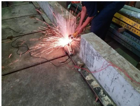
รูปที่ 3.1.22 การตัดลวดอัดแรง
