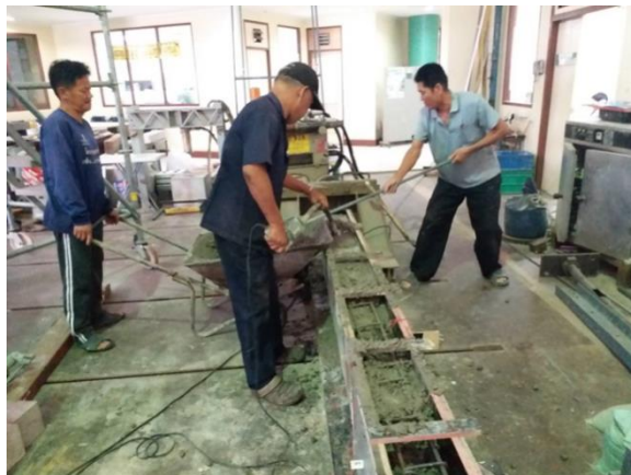
รูปที่ 3.1.11 การจี้คอนกรีตระหว่างหล่อคาน
