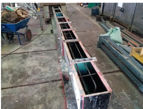
รูปที่ 3.1.17 การติดตั้งค้ำยัน
