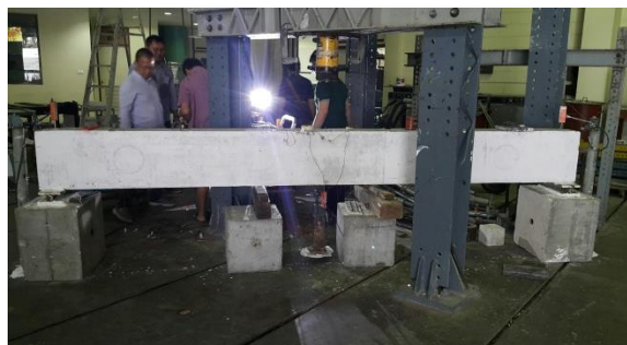
รูปที่ 3.2.6 การติดตั้งอุปกรณ์ทดสอบ
