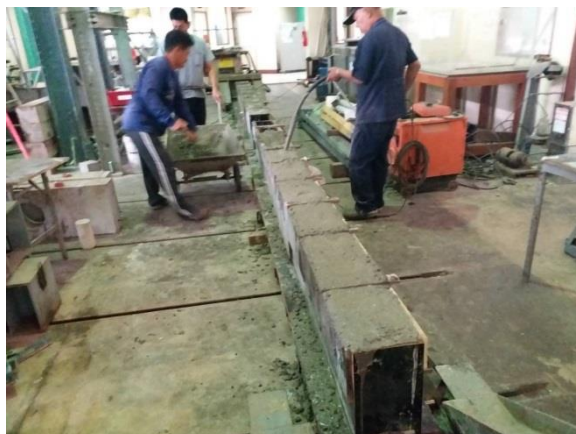
รูปที่ 3.1.12 การแต่งผิวหน้าคาน
