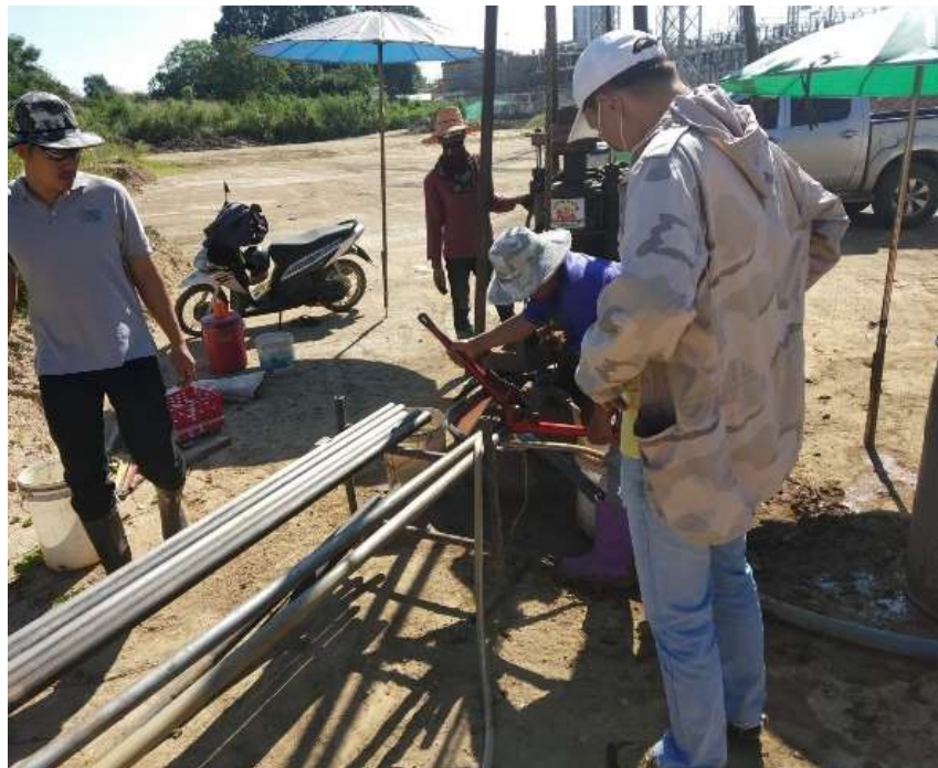
รูปที่ 4.3 การทดสอบตอกทะลวงแบบมาตรฐาน Standard Penetration Test, SPT
