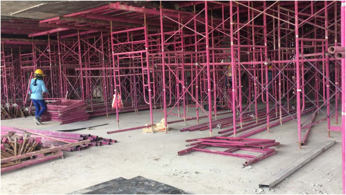
รูปที่ ค 9 รื้อนั่งร้าน
