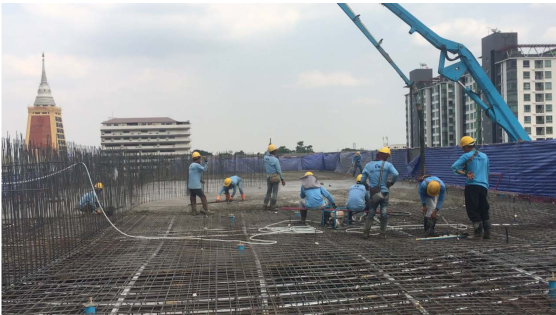
รูปที่ ค 6 เทคอนกรีต
