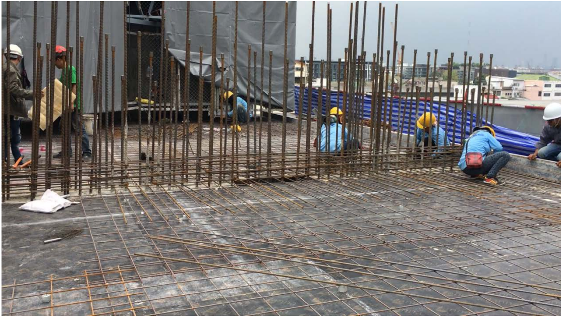
รูปที่ ค 5 วางเหล็กเสริมบริเวณหัวเสา
