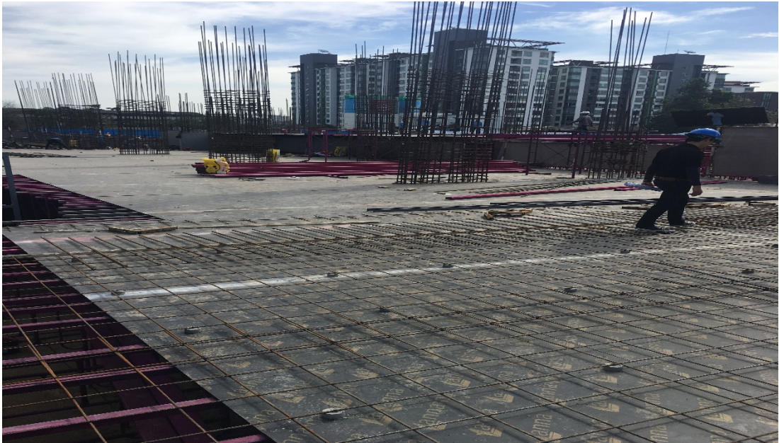
รูปที่ ค 3 วางเหล็กเสริมล่าง
