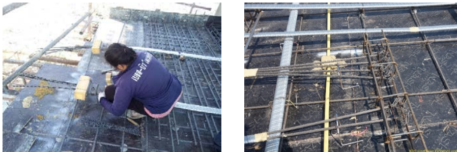
รูปที่ 3.5 แสดงการติดตั้งลวดอัดแรงและยึดกับสมอแบบข้าง
