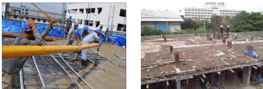
รูปที่ 3.7 แสดงการเทคอนกรีตและบ่มคอนกรีต
