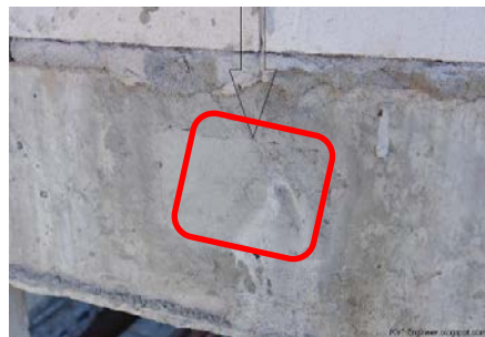
รูปที่ 3.9 แสดงการอุดเข้าหลังจากตัดปลายลวด
