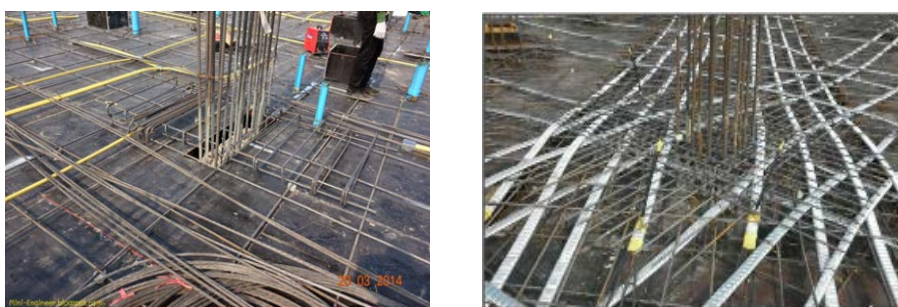
รูปที่ 3.6 แสดงการวางเหล็กเสริมบน
