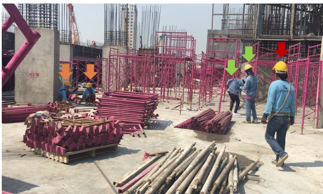
รูปที่ 2.1 แสดงการแยกประเภทงานของกิจกรรมตั้งนั่งร้านวิธีการประเมินค่าผลิตภาพ
