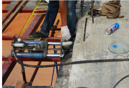
รูปที่ 3.8 แสดงการดึงลวดอัดแรง
