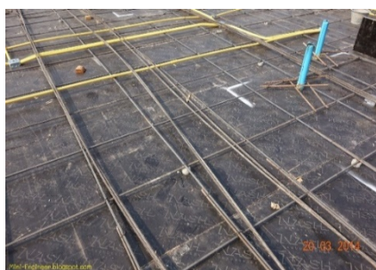
รูปที่ 3.4 แสดงการวางเหล็กเสริมล่าง
