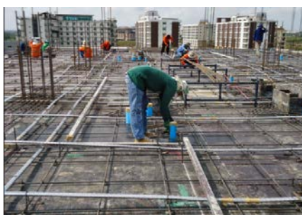
รูปที่ 3.4 แสดงการวางเหล็กเสริมล่าง
