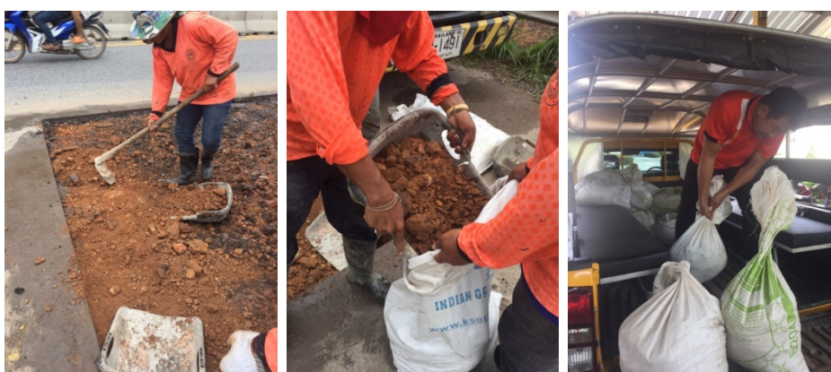
รูปที่ 4.8 การเก็บตัวอย่างวัสดุชั้นทางดินผสมซีเมนต์ที่เกิดความเสียหาย
