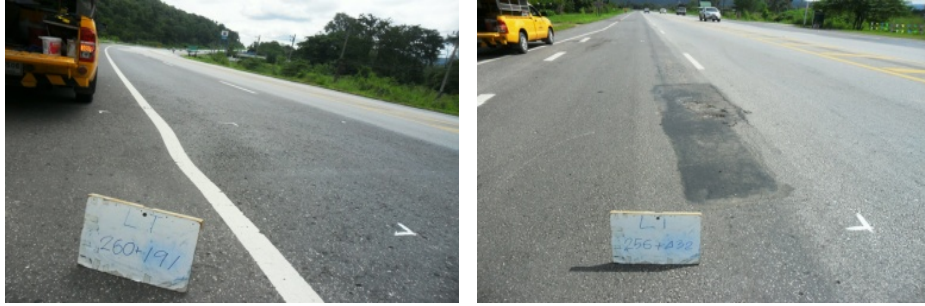
รูปที่ 4.2 รูปแสดงความเสียหายแบบการปูตุน (Shoving) ในภาคสนาม
