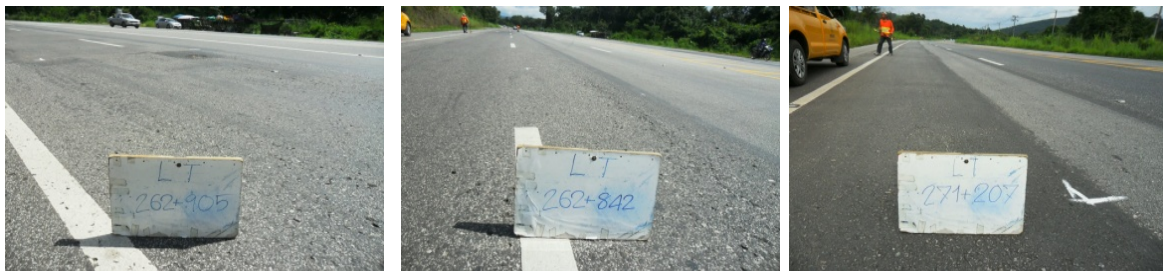
รูปที่ 4.3 รูปแสดงความเสียหายแบบร่องล้อ (Rutting) ในภาคสนาม
