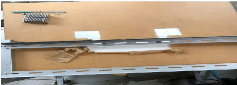
ภาพที่ 3.11 แสดงลักษณะที่โครงที่ติดตั้งอุปกรณ์ใส่กล่องควบคุม
