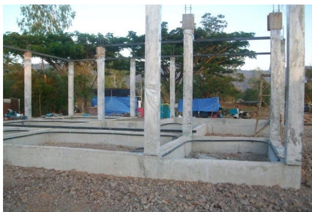
รูปที่ 2.4 งานคอนกรีตเสา
