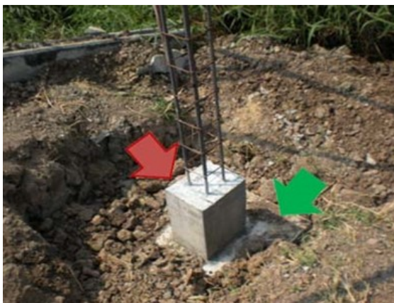
รูปที่ 2.3 งานคอนกรีตฐานราก
