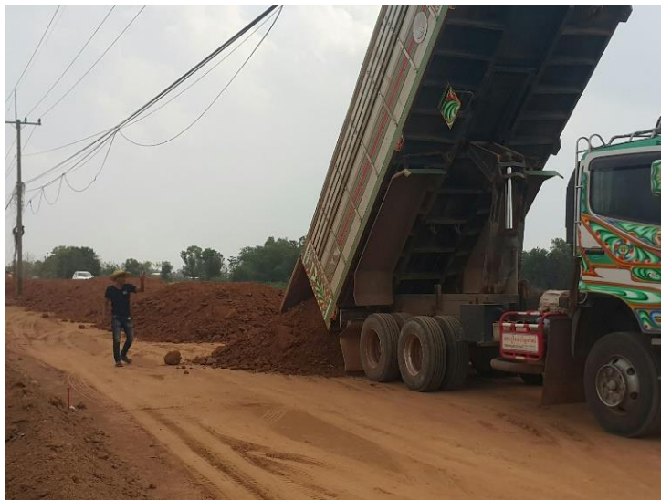
รูปที่ 1.1 การลงวัสดุชั้นรองพื้นทาง
