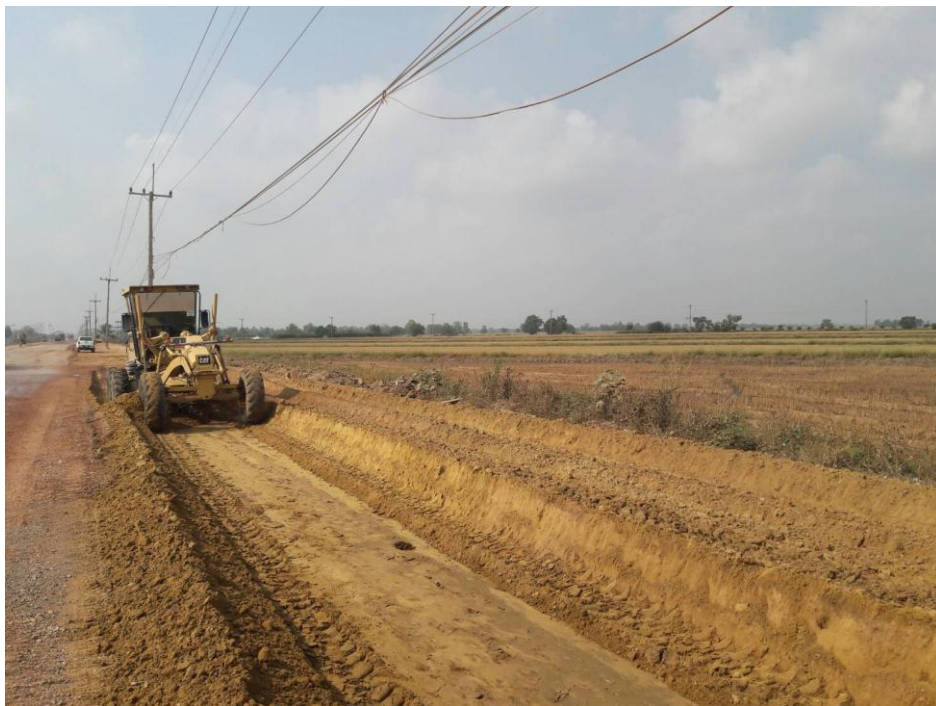
รูปที่ 3.3 การทำงานของรถเกรดมอเตอร์
