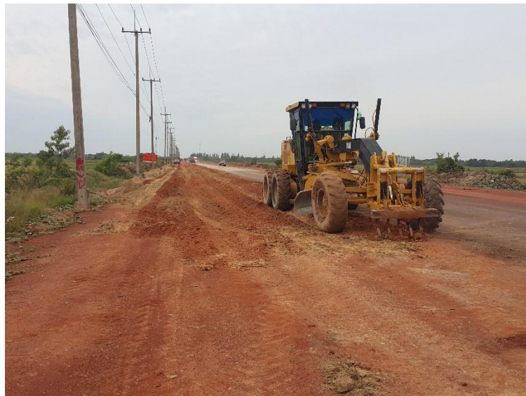
รูปที่ ค 4 งาน Mixed Process ชั้นลูกรัง
