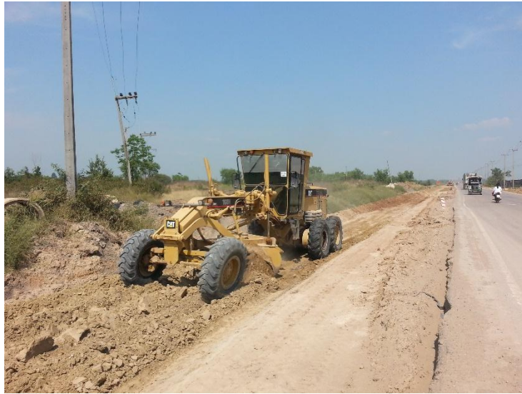
รูปที่ ค 3 งาน Mixed Process ทรายถมคันทาง
