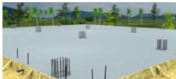
6.เทพื้นคอนกรีต
