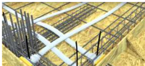
4.ติดตั้ง Anchorage และท่อ Grout
