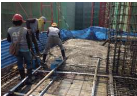
ภาพที่ 3-3 กิจกรรมที่ก่อให้เกิดผลผลิตภาพโดยตรง (เกลี่ยคอนกรีต)
