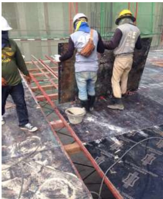
ภาพที่ 4-9 คนงานขนไม้แบบมาติดตั้ง
