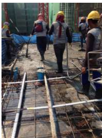
ภาพที่ 4-22 แสดงการจี้คอนกรีตของคนงาน
