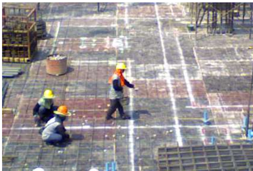
ภาพที่ 4-24 แสดงการทำงานของคนงานหลนลูกปูน
