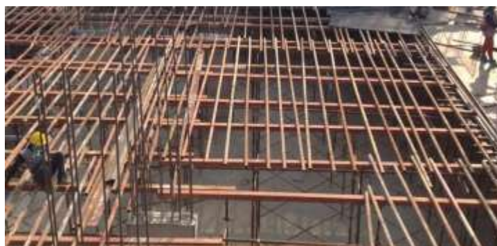
ภาพที่ 4-6 การวางเหล็กกล่อง
