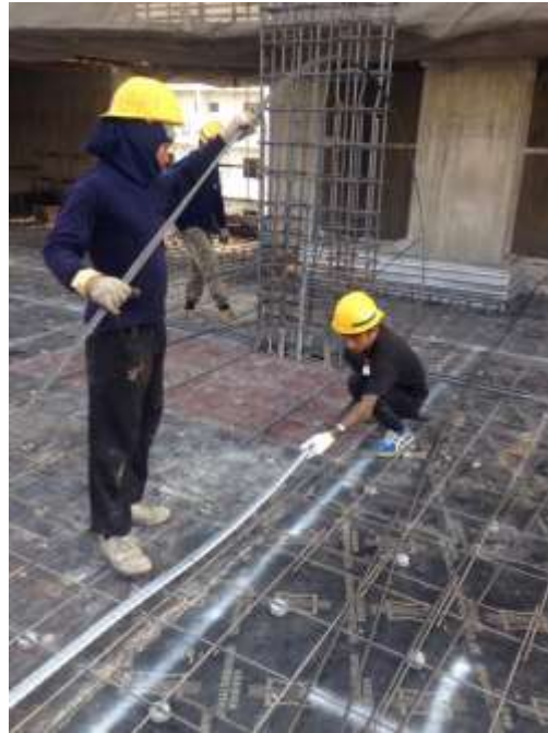
ภาพที่ 4-18 คนงานสอดลวดเข้าท่อ Sheath
