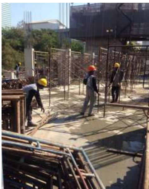
ภาพที่ 4-5 แสดงการติดตั้งนั่งร้านของคนงาน
