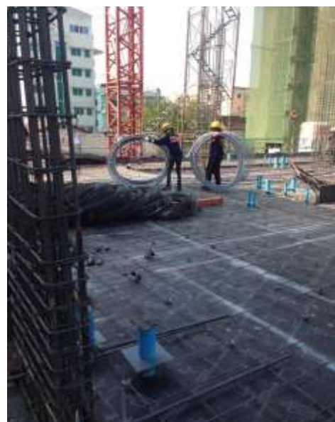
ภาพที่ 4-17 คนงานเคลื่อนย้ายท่อ Sheath
