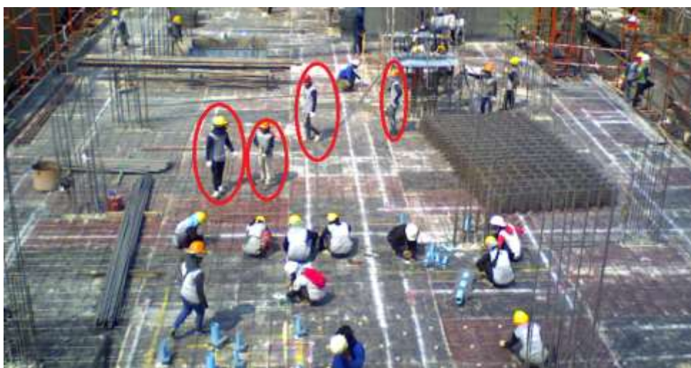
ภาพที่ 4-15 การรอคอยงานของคนงานยกเหล็กไวเมท
