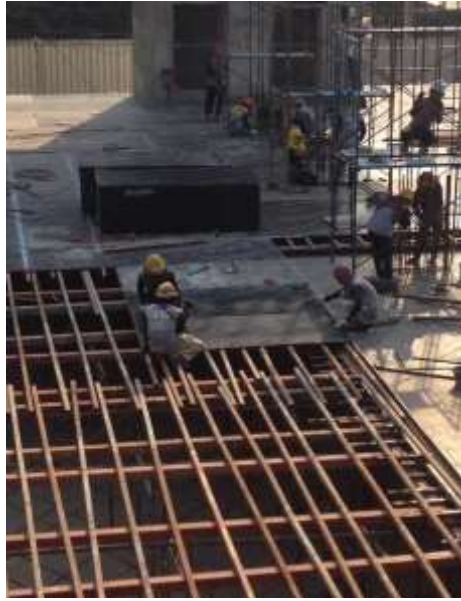
ภาพที่ 4-10 คนงานติดตั้งไม้แบบ
