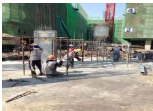
ภาพที่ 4-3 คนงานติดตั้งนั่งร้าน
