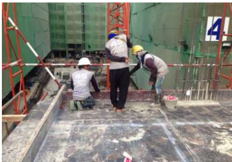
ภาพที่ 4-12 การช่วยติดตั้งไม้แบบของคนที่ขนย้ายไม้แบบ
