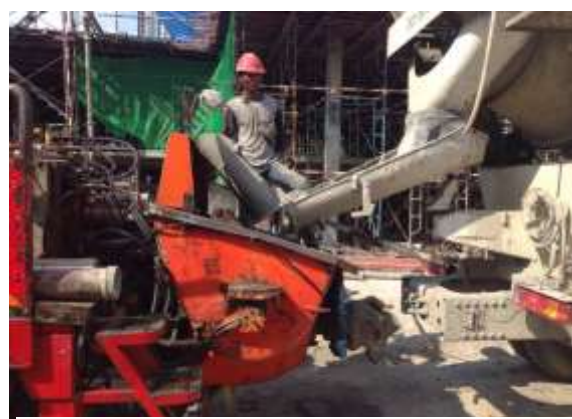
ภาพที่ 4-21 แสดงการปล่อยคอนกรีตเข้าปั๊ม
