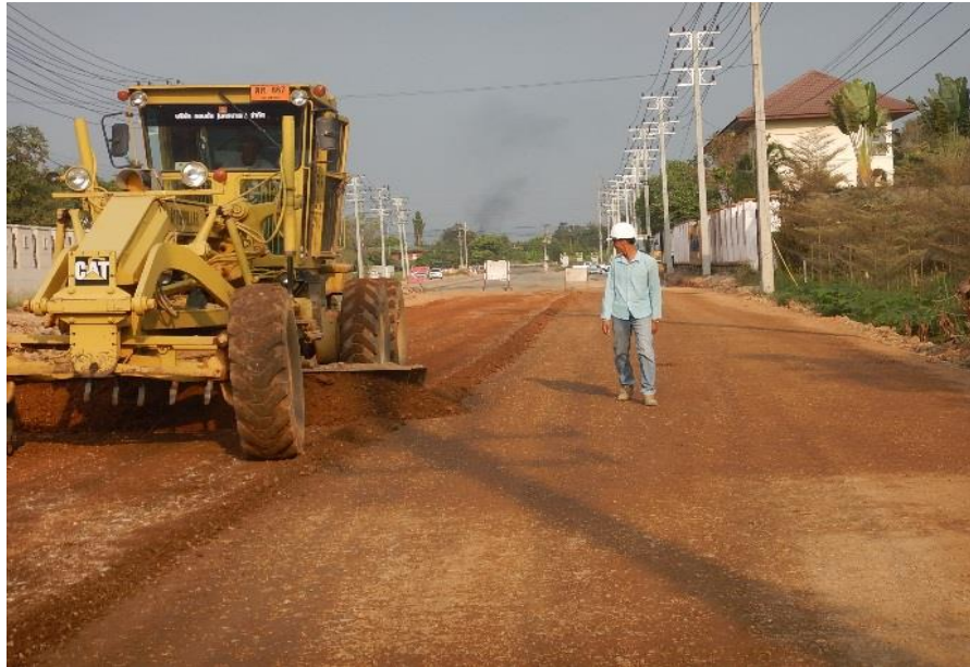
รูปที่ 3.14 การทำงานของงานรองพื้นชนิดลูกรัง
