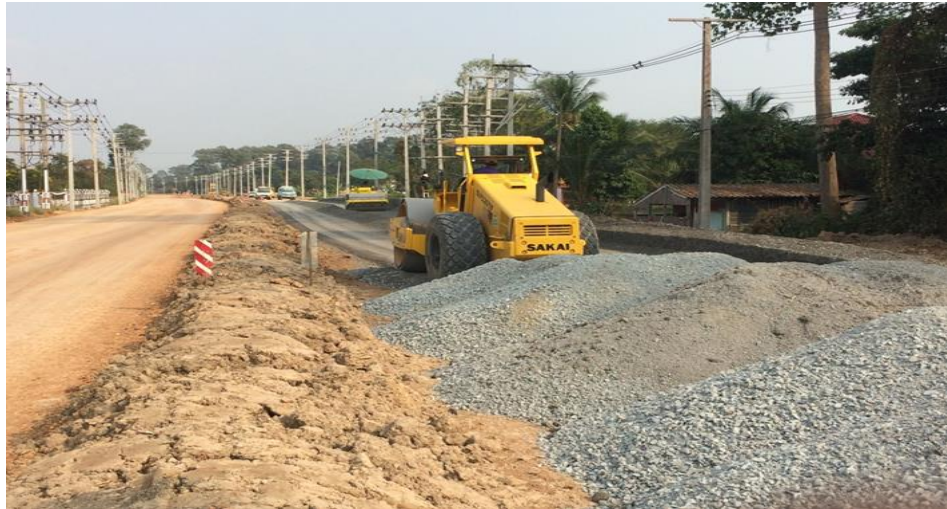
รูปที่ ๓ แสดงลักษณะการทำงาน (บดอัดหินคลุก)
