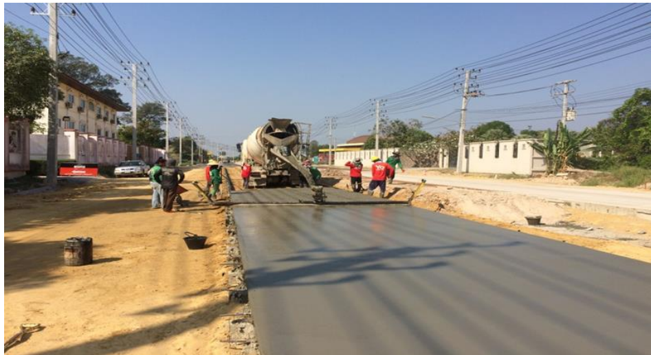
รูปที่ ข 12 แสดงลักษณะการทำงาน (เทคอนกรีตผิวจราจรเสริมเหล็ก)
