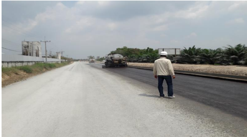
รูปที่ ข 5 แสดงลักษณะการทำงาน (Prime coat)
