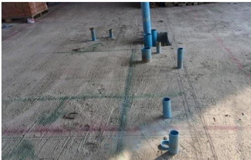
รูปที่ 3.2 ตีเส้นลายไว้เพื่อเตรียมก่ออิฐ
