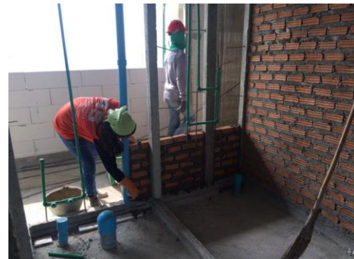
รูปที่ 3.5 งานก่ออิฐมอญ
