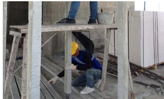
รูปที่ 3.3 ติดตั้งเสาเอ็น
