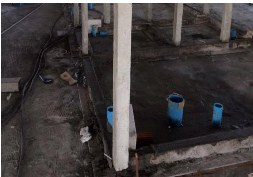
รูปที่ 3.4 ทำ Curb
