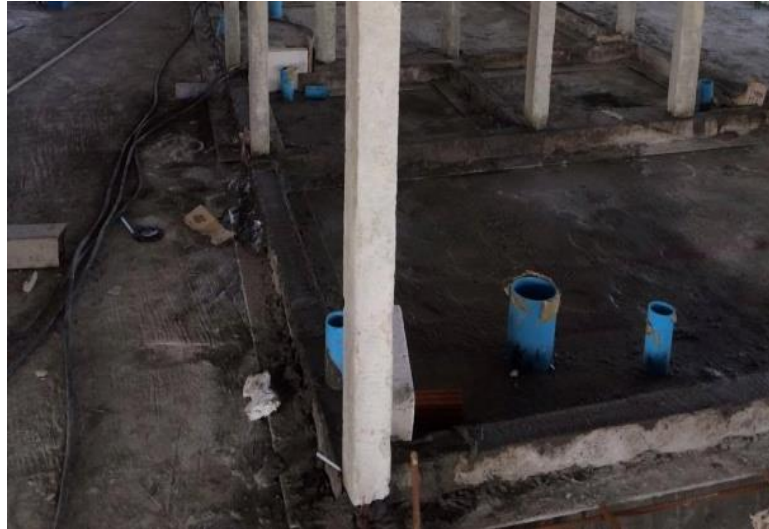
รูปที่ 3.4 ทำ Curb
