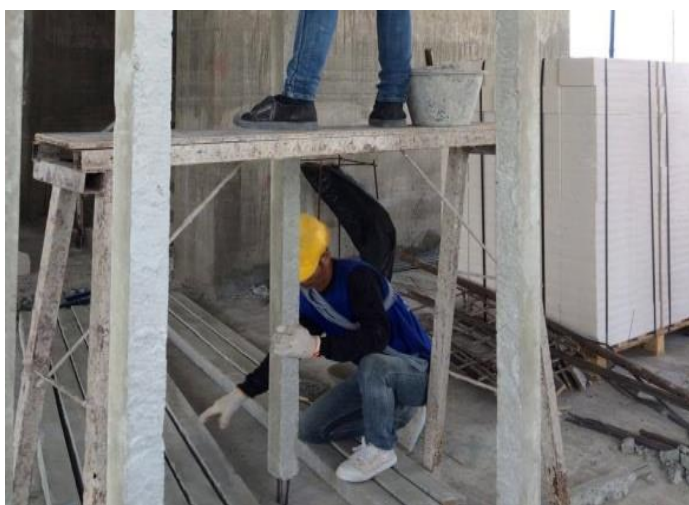
รูปที่ 3.3 ติดตั้งเสาเอ็น
