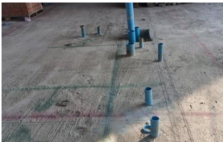
รูปที่ 3.2 ตีเส้นลายไว้เพื่อเตรียมก่ออิฐ
