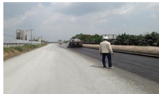
รูปที่ 3.17 งานลาดนํ้ายาง Prime Coat
