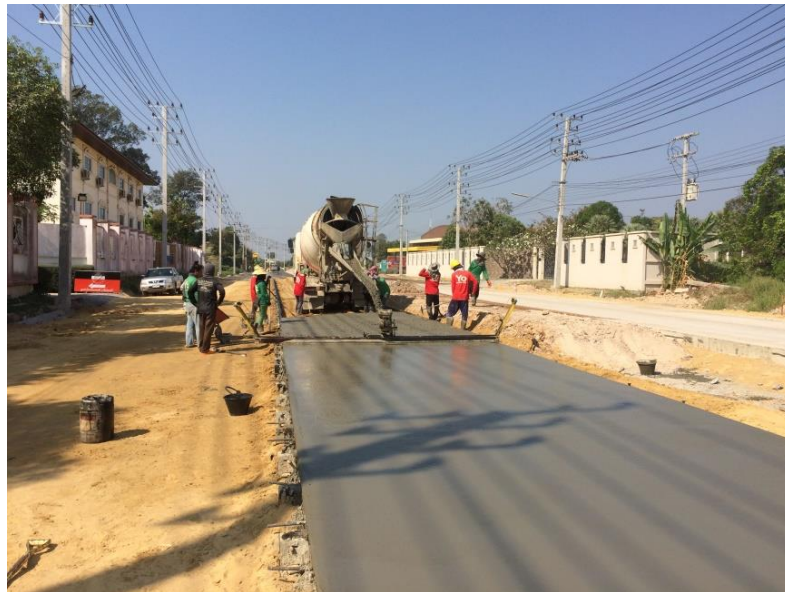
รูปที่ ข 12 แสดงลักษณะการทำงาน (เทคอนกรีต)
