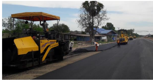
รูปที่ 3.15 งานปูแอสฟัลต์ติกคอนกรีต (Binder Course)
