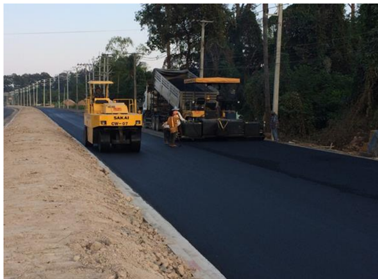
รูปที่ ข 6 แสดงลักษณะการทำงาน(ปูแอสฟัลต์ติกคอนกรีตและบดทับ)
