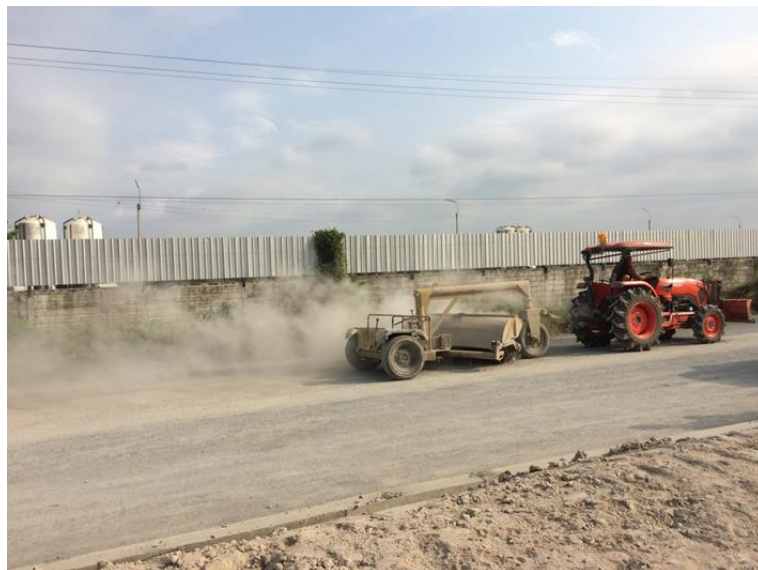
รูปที่ ข 4 แสดงลักษณะการทำงาน(ทำความสะอาดก่อนPrime Coat)
