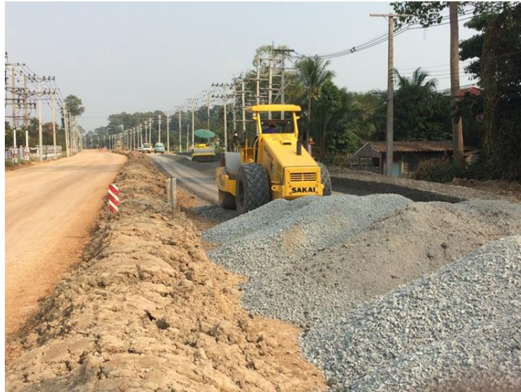
รูปที่ ข 3 แสดงลักษณะการทำงาน(บดทับพื้นทางหินคลุก)
