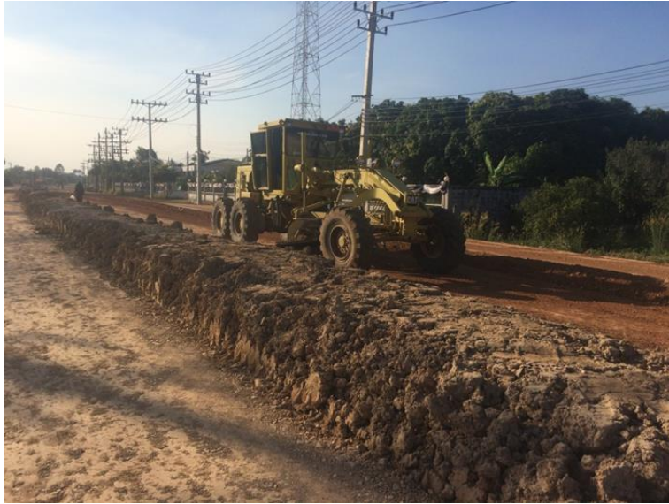
รูปที่ ข 1 แสดงลักษณะการทำงาน(การตัดเกรดรองพื้นหินคลุก)
