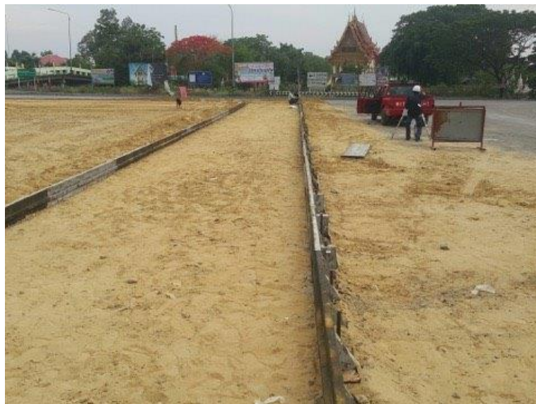
รูปที่ ข 10 แสดงลักษณะการทำงาน (เข้าแบบผิวจราจรคอนกรีต)
