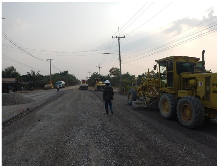
รูปที่ ข 14 แสดงลักษณะการทำงาน (ตัดเกรดหินคลุก)
