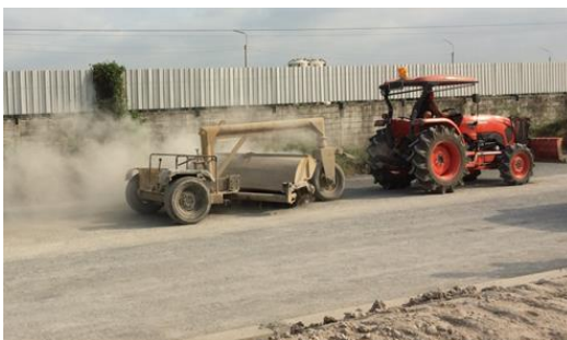
รูปที่ 3.16 งานทำความสะอาด
