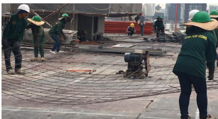
รูปที่ 4.3 แสดงกิจกรรมการวางเหล็กเสริม
