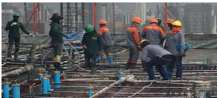
รูปที่ 4.5 แสดงกิจกรรมการเทคอนกรีต
