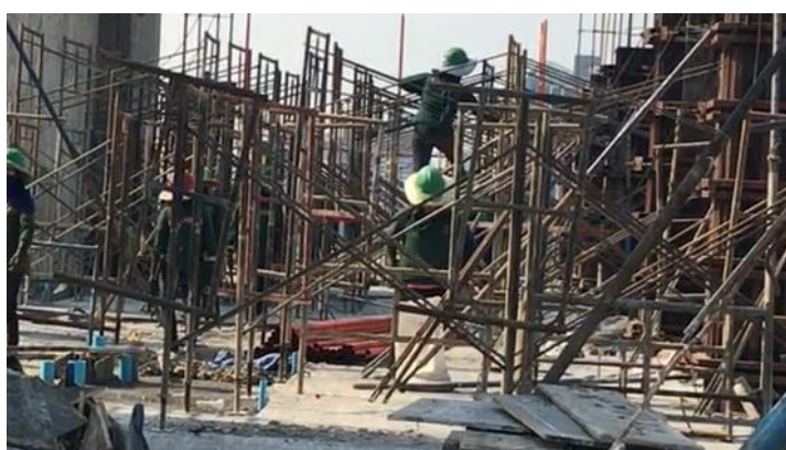
รูปที่ 4.2 แสดงกิจกรรมการติดตั้งนั่งร้าน
