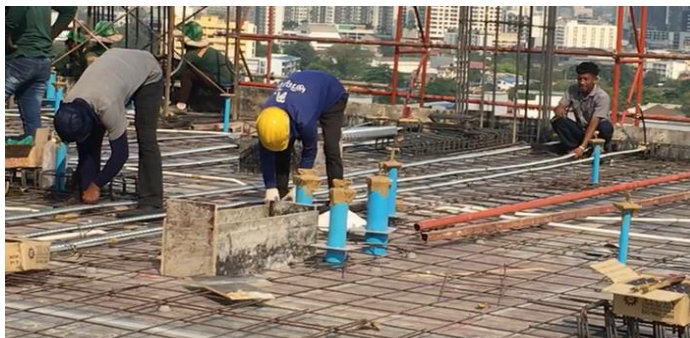
รูปที่ 4.4 แสดงกิจกรรมการติดตั้งลวดสลิง
