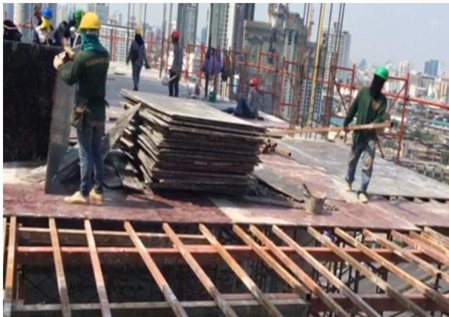
รูปที่. ค 2 ปูไม้แบบรองพื้น
