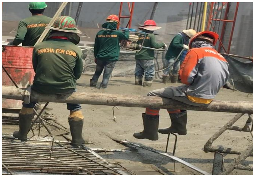
รูปที่. ค 6 เทคองกริตพื้น
