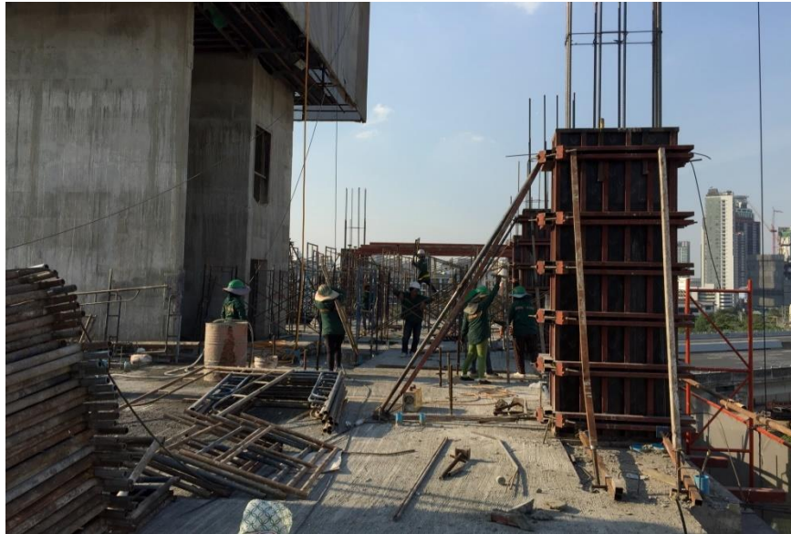
รูปที่. ค 1 ตั้งนั่งร้านรับพื้น
