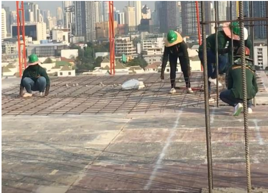
รูปที่. ค 3 วางเหล็กล่าง
