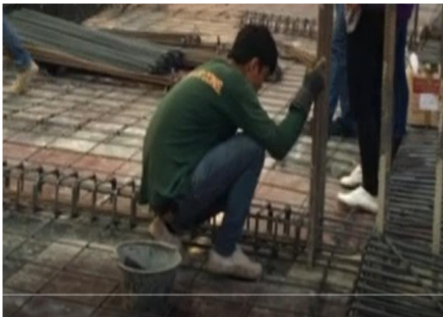
รูปที่. ค 4 วางเหล็กแรงเหวี่ยงและเหล็กบน
