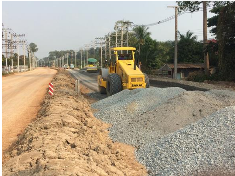
รูปที่ 3.14 การทำงานของงานพื้นทางชนิดหินคลุก
