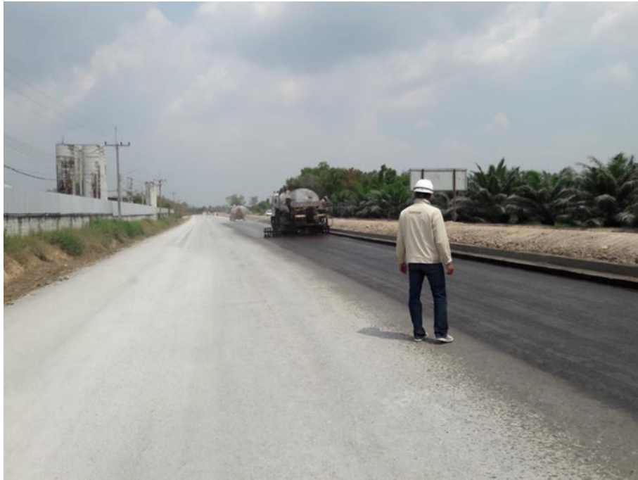
รูปที่ ข 5 แสดงลักษณะการทำงาน (Prime coat)
