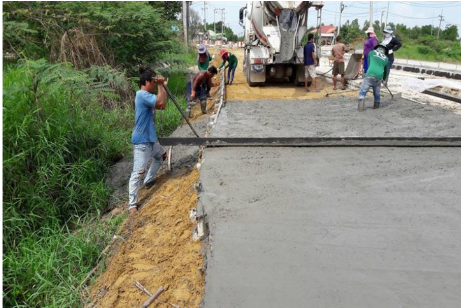
รูปที่ ข 13 แสดงลักษณะความเสี่ยง (แบบแตกขณะเทคอนกรีต)
