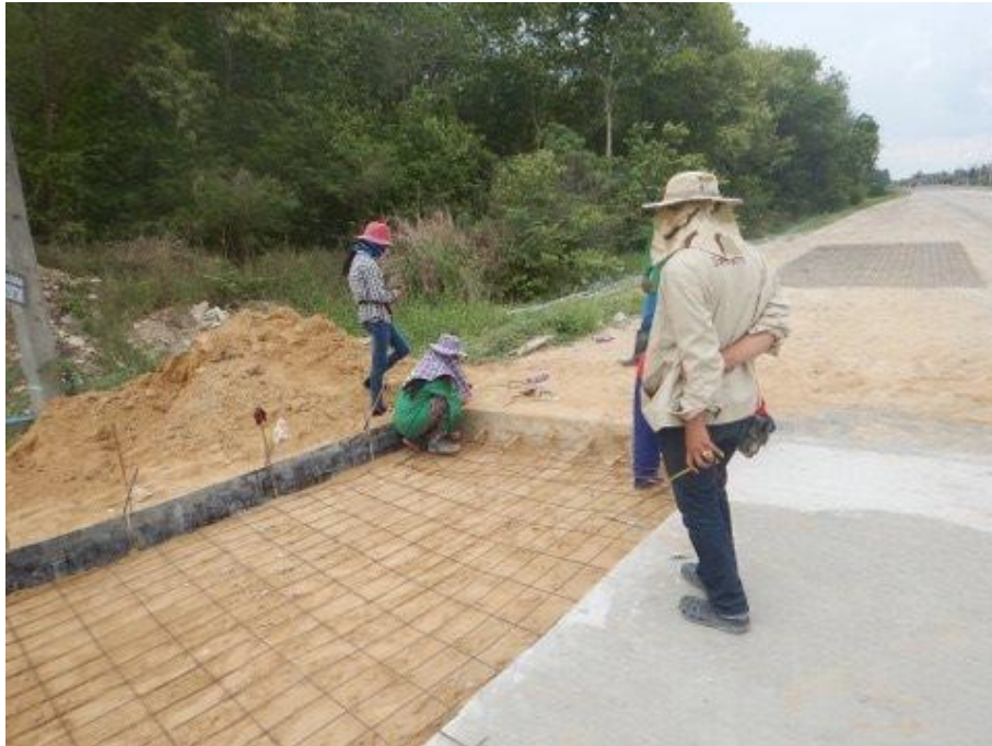
รูปที่ ข 11 แสดงลักษณะการทำงาน (ติดตั้งเหล็กเสริม)
