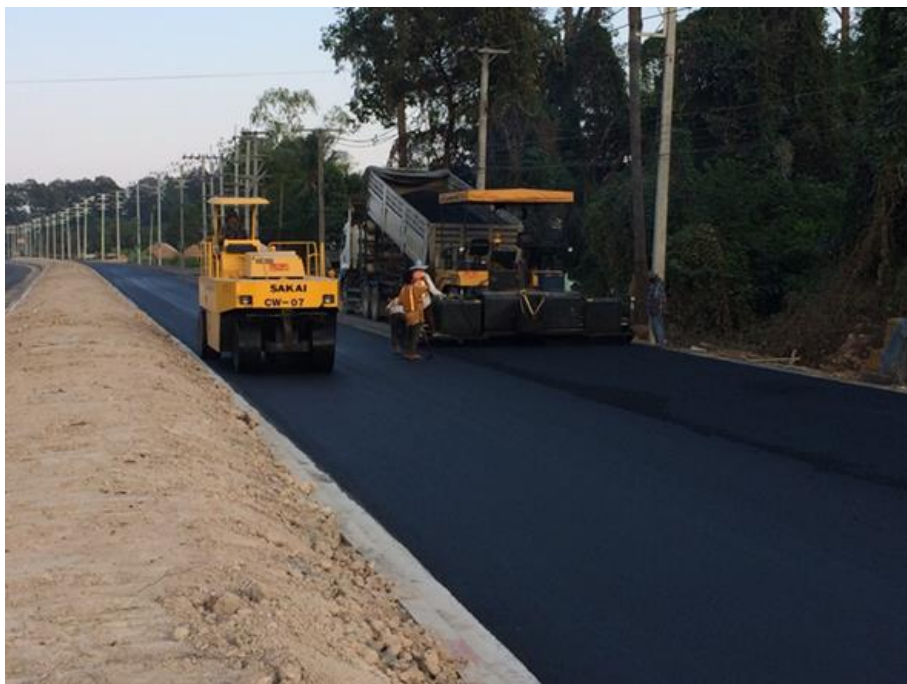
รูปที่ ข 6 แสดงลักษณะการทำงาน (ปูยางแอสฟัลติกคอนกรีตและบดทับ)
