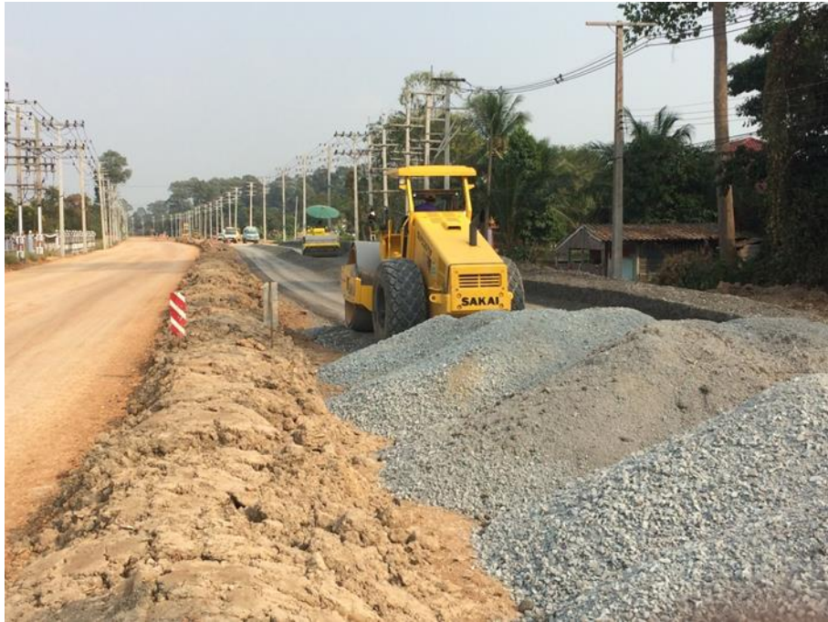
รูปที่ ข 3 แสดงลักษณะการทำงาน (บดอัดหินคลุก)
