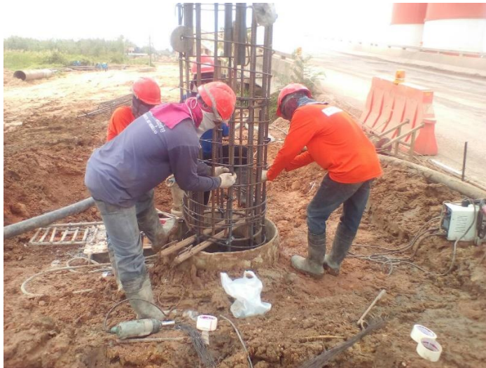
รูปที่ 1.1 สภาพการทำงานก่อสร้างเสาเข็มเจาะระบบเปียก กิจกรรมขณะติดตั้งเหล็กเสริม
