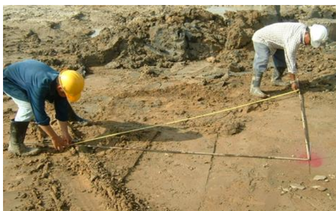
รูป 4.3 ช่างสำรวจกำหนดตำแหน่งเสาเข็ม
