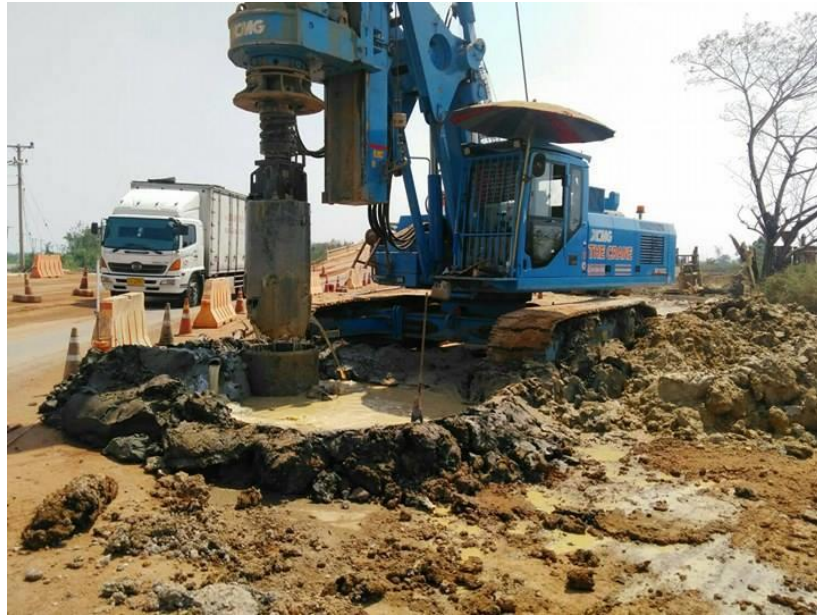
รูป 4.8 แสดงการใช้เครื่องจักรติดตั้งถังทำความสะอาดหลุมเจาะ (Cleaning Bucket)
