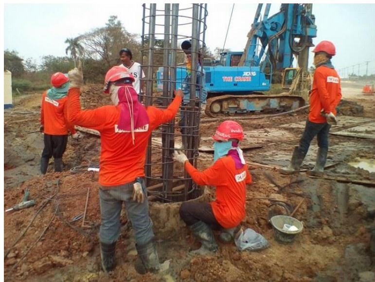
รูป 4.9 แสดงการติดตั้งเหล็กเสริม
