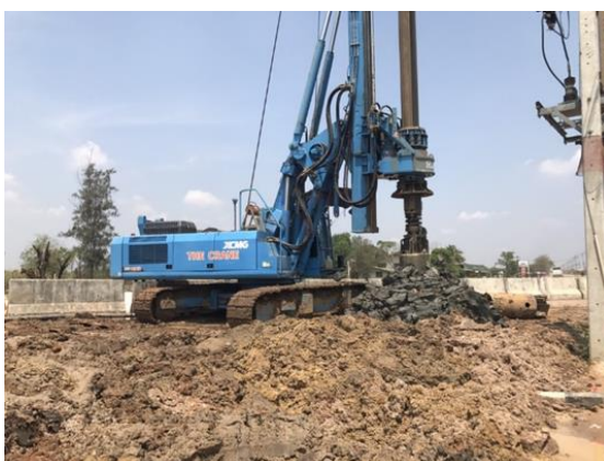
รูป 4.6 แสดงการเจาะเสาเข็ม
