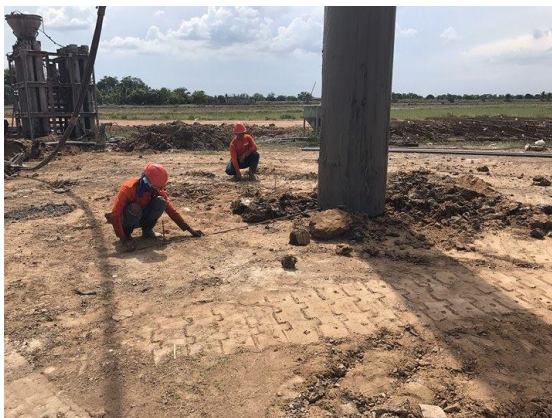
รูป 4.5 แสดงการควบคุมไม่ให้ปลอกเหล็กเบี่ยงเบน
