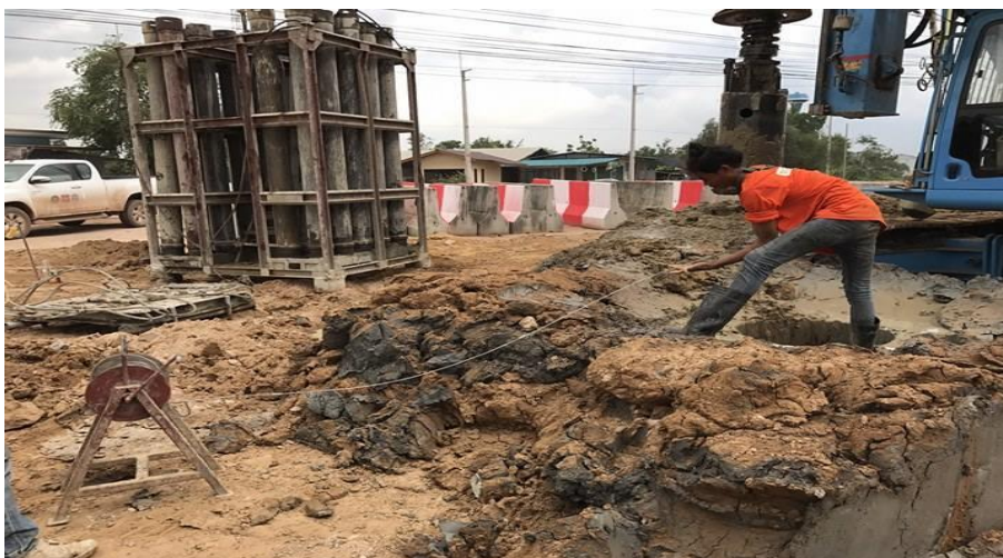
รูป 4.7 ใช้สลิงตรวจสอบความลึกก้นหลุม
