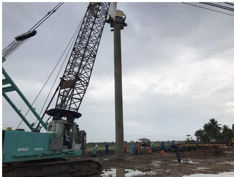
รูป 4.14 แสดงการถอนปลอกเหล็กออกจากหลุมเจาะ
