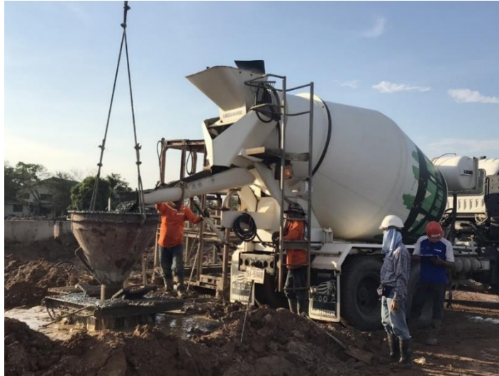
รูป 4.12 แสดงการเทคอนกรีต
