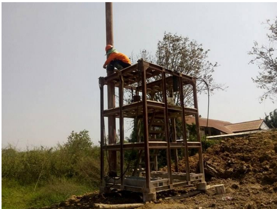
รูป 4.11 การติดตั้งท่อเทคอนกรีต (TREMIE TUBE)
