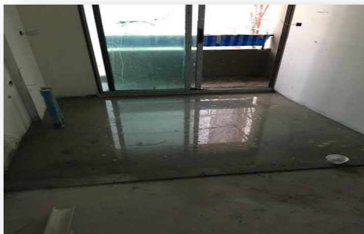
รูปที่ 1.1 เกิดน้ำท่วมขังจากพายุฝนในส่วนของระเบียง และห้องครัวจนไม่สามารถปูกระเบื้องได้
