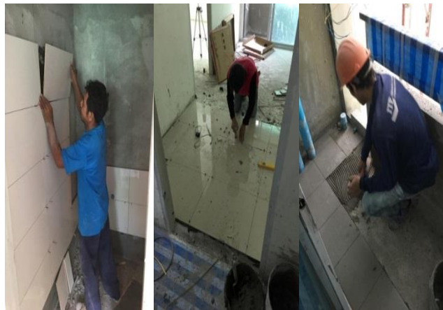
รูปที่ 3.9 ขั้นตอนการปูกระเบื้อง
