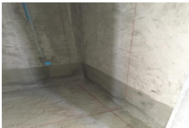
รูปที่ 3.7 ขั้นตอนการตี Line กระเบื้อง
