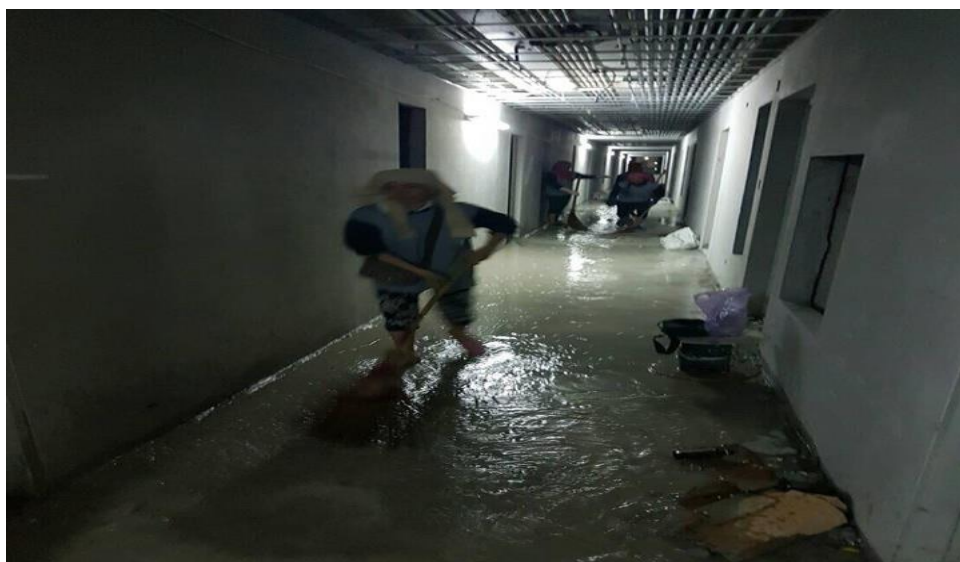
รูปที่ 3.15 ความเสี่ยงที่เกิดจากคนงานเปิดน้ำทิ้งทั้งคืน ส่งผลให้น้ำท่วมทางเดินส่วนกลาง ไม่สามารถตรวจงานกันซึมต่อได้ ต้องทำการเคลียน้ำให้แห้งสนิทก่อน
