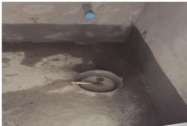
รูปที่ 3.6 ขั้นตอนการทากันซึม
