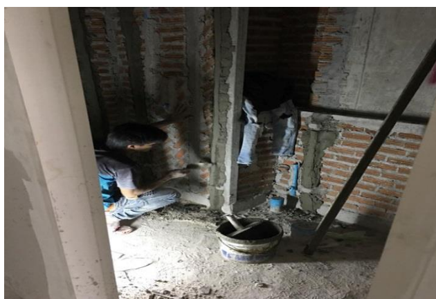
รูปที่ 3.4 ขั้นตอนการจับปูน
