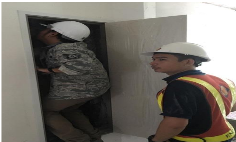
รูปที่ ข 4 รูปแสดงการตรวจกันซึม
