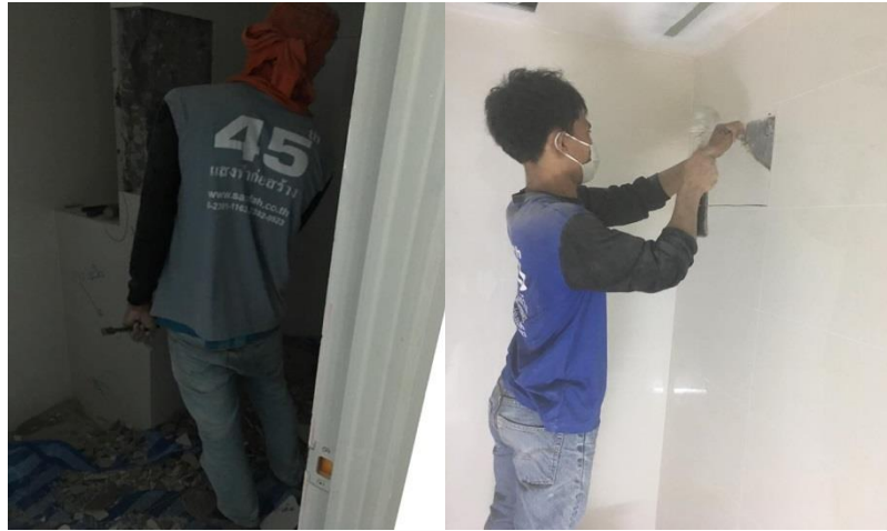
รูปที่ ข 7 รูปแสดงการแก้ไขกระเบื้องที่ไม่ผ่านการตรวจ
