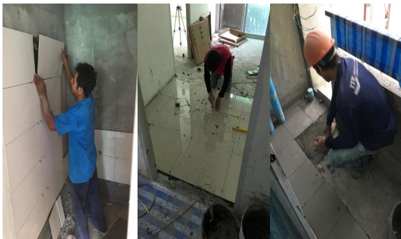
รูปที่ ข 5 รูปแสดงการปูกระเบื้องผนังห้องน้ำ พื้นห้องครัว และ ระเบียง
