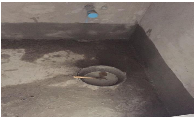
รูปที่ ข 3 รูปแสดงการทากันซึมภายในห้องน้ำ
