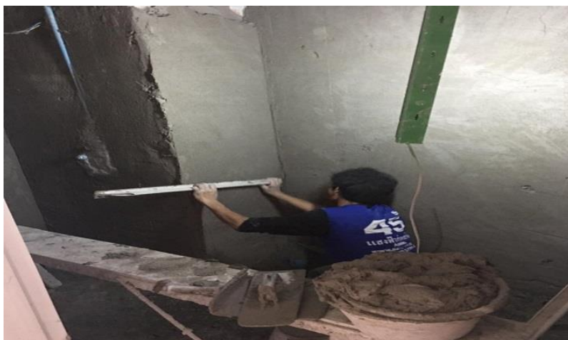
รูปที่ ข 2 รูปแสดงการฉาบภายในห้องน้ำ
