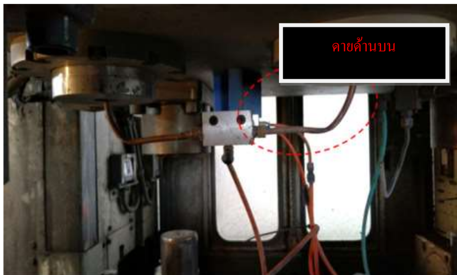
ภาพที่ 4.3 ก่อนและหลังติดตั้งชุดลมเป่าเศษ
