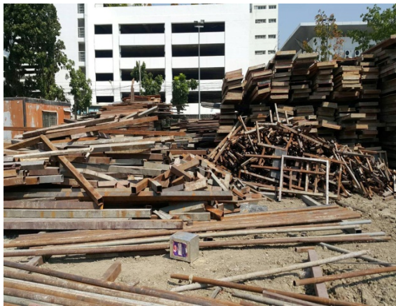
รูปที่ 1.1 เศษไม้และเหล็กที่ใช้ในงานแบบหล่อคอนกรีตที่ไม่สามารถนำกลับมาใช้งานได้
