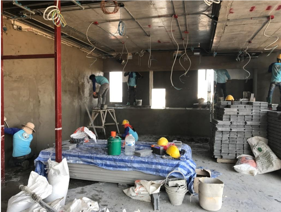
รูปที่ จ 13 แสดงกิจกรรมการขึ้นปูน/ปาดสามเหลี่ยม/ปั้นหน้าลงฟอง
