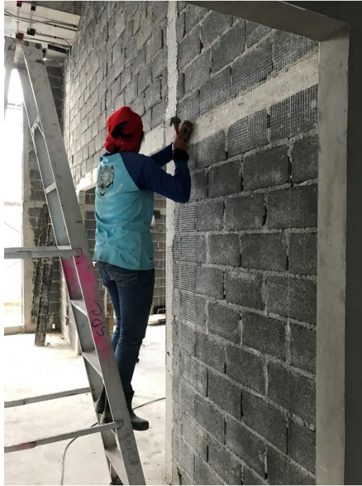
รูปที่ จ 3 แสดงกิจกรรมการติดตะแกรงกรงไก่
