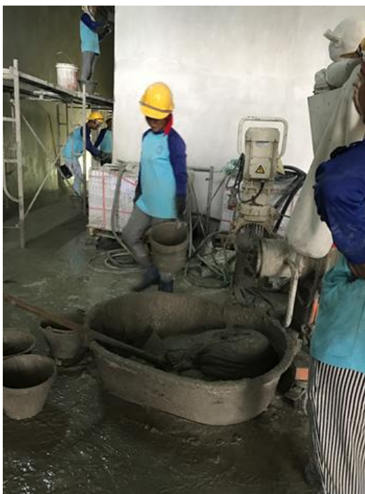
รูปที่ จ 5 แสดงกิจกรรมการขึ้นปูน/ปาดสามเหลี่ยม/ป็นหน้าลงฟอง
