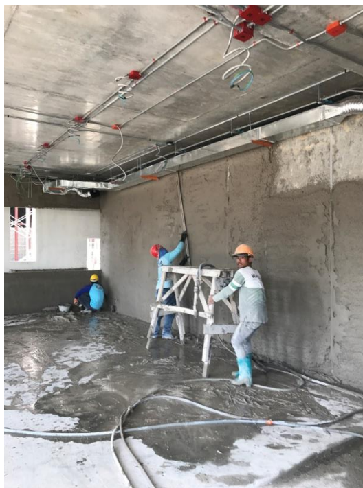
รูปที่ จ 8 แสดงกิจกรรมการขึ้นปูน/ปาดสามเหลี่ยม/ป็นหน้าลงฟอง
