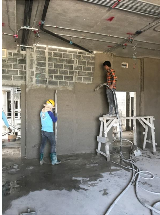
รูปที่ จ 9 แสดงกิจกรรมการขึ้นปูน/ปาดสามเหลี่ยม/ป็นหน้าลงฟอง
