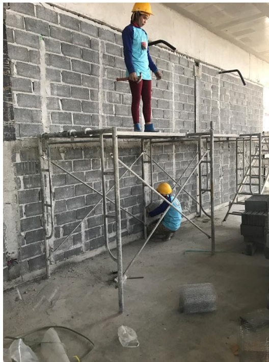
รูปที่ จ 4 แสดงกิจกรรมการติดตะแกรงกรงไก่
