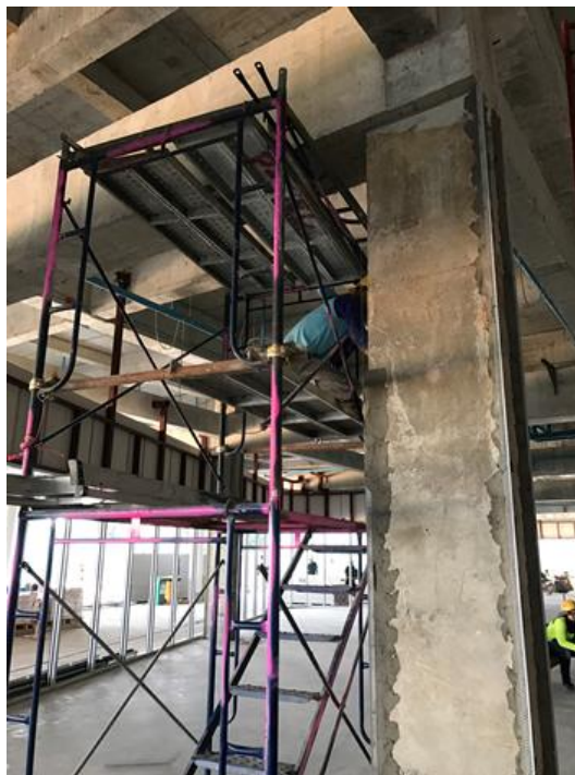
รูปที่ จ 2 แสดงกิจกรรมการหาแนวตั้ง/จับเชื่อมจับปุม
