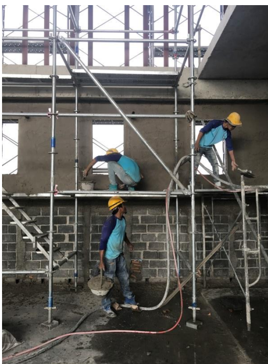
รูปที่ จ 6 แสดงกิจกรรมการขึ้นปูน/ปาดสามเหลี่ยม/ป็นหน้าลงฟอง
