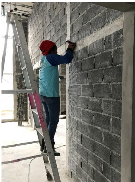
รูปที่ 4.2 ขั้นตอนติดตั้งตะแกรงกรงไก่
