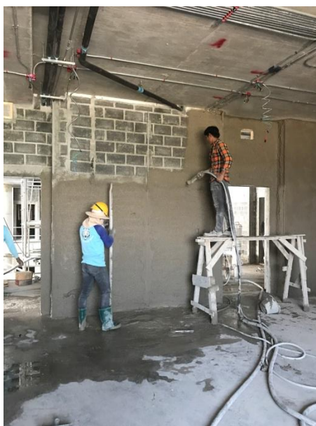
รูปที่ 4.3 การใช้เครื่องพ่นปูน ช่วยในงานฉาบปูน
