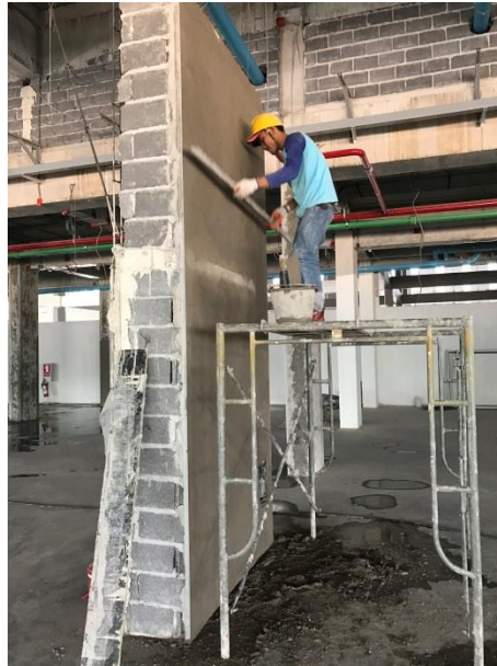
รูปที่ 4.4 ขั้นตอนฉาบผนังเรียบโดยใช้สามเหลี่ยมปาดปูน
