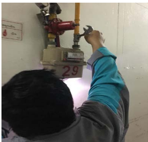
ภาพที่ 4.5 แสดงการถอดอุปกรณ์ทำสะอาด
