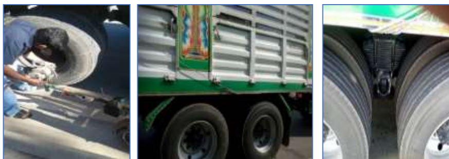
ภาพที่ 3.3 แสดงสภาพการปรับปรุงและติดตั้งอุปกรณ์
