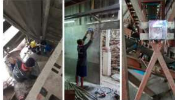
ติดตั้งอุปกรณ์โดยอุณหภูมิเตาเผาที่ 1 ติดตั้งอุปกรณ์วัดอุณหภูมิเตาเผาที่ 2 ติดตั้งอุปกรณ์โดยอุณหภูมิสายพานลำเลียง
