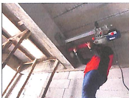
ภาพที่ 1.1 การเจาะช่องเปิดในคาน
