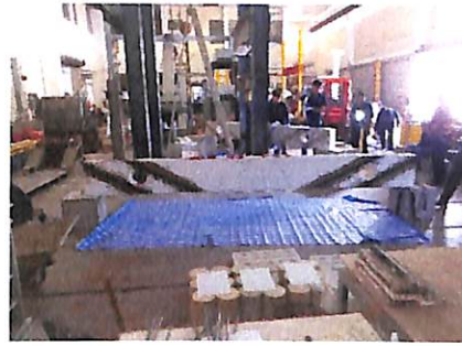
b) ติดแผ่น SMARTFIBER-SHEET UT70-30 เสร็จ
