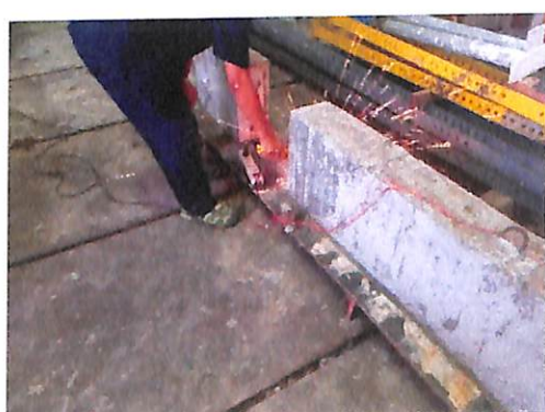
(c) การตัดเหล็กเสริมอัดแรงขึ้นทดสอบ
