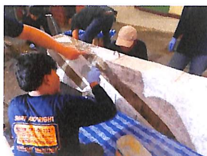
ภาพที่ 3.19 การไป้อากาศเตรียมผิวก่อนติดแผ่น CFRP
