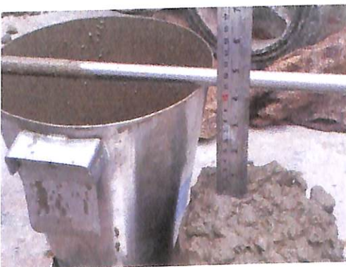
(c) ตรวจสอบค่าการยุบตัวของคอนกรีต
