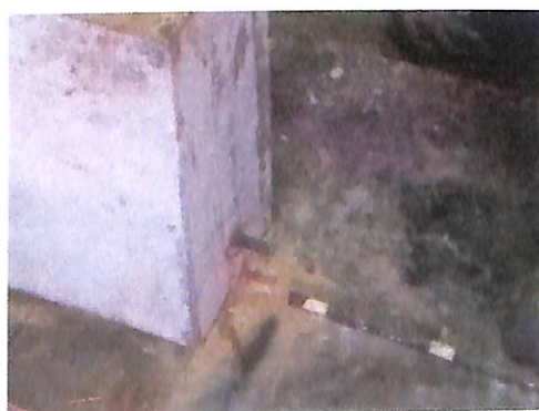
(d) เหล็กเสริมอัดแรงที่ตัดขาดแล้ว
