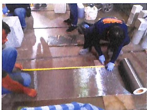
ภาพที่ 3.20 การตัดแผ่น SMARTFIBER - SHEET UT70-30 ให้ได้ขนาดที่ออกแบบไว้
