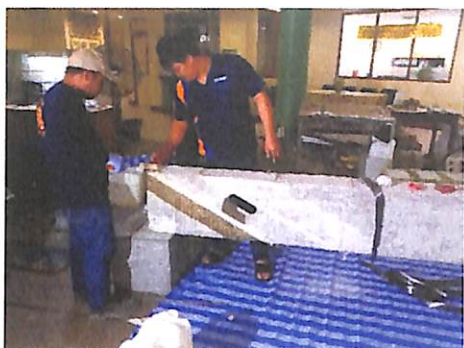
ภาพที่ 3.18 ทาชั้น Primer ด้วย SMART CF-Resin
