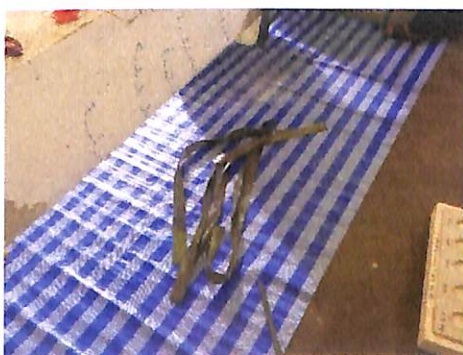
ภาพที่ 3.20 การตัดแผ่น SMARTFIBER - SHEET UT70-30 ให้ได้ขนาดที่ออกแบบไว้
