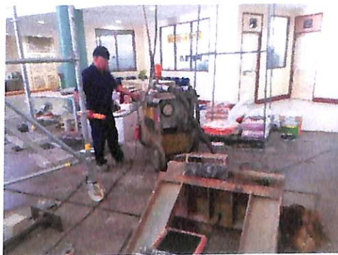
(a) เครื่องดิงเหล็กเสริมอัดแรง
