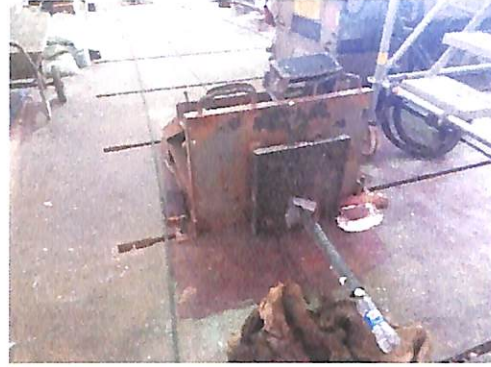
ภาพที่ 3.8 การติดตั้งเหล็กเสริมอัดแรงกับแท่นยึด
