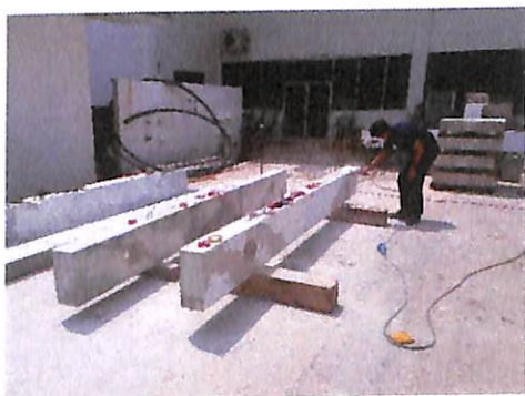
ภาพที่ 3.17 การขัดผิวคอนกรีตเพื่อเตรียมผิวก่อนติดตั้ง CFRP
