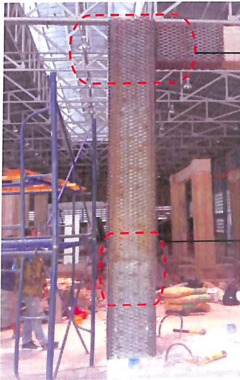
ภาพที่ 3.8 การติดตั้งตะแกรงเหล็กฉีกที่เสาและคานโดยเชื่อมติดกับเหล็กฉาก
