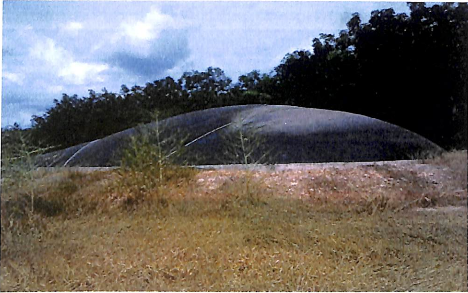
ภาพประกอบที่ 1 บ่อ Cover lagoon ขนาด กว้าง 13 เมตร ยาว 15 เมตร ลึก 7 เมตร
