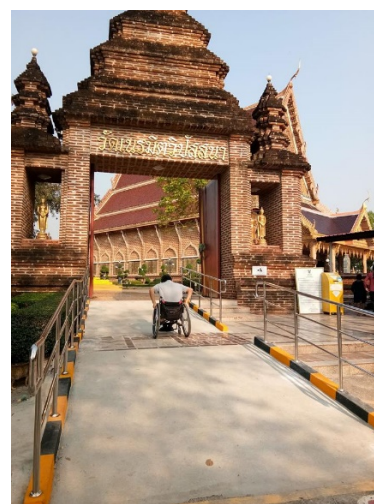
วัดนรมิตวิปัสณา ก่อนการปรับปรุง ทางลาดมีความชันมากและไม่มีราวจับ และภาพภายหลังการปรับปรุง
