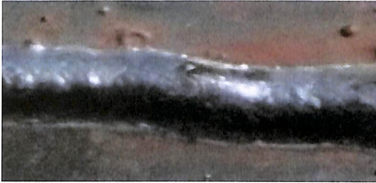
ก. รอยเชื่อมที่เกิดขึ้นจากการติดตั้งวงจร Valley Fill แบบที่ 1 ที่ DC Bus
