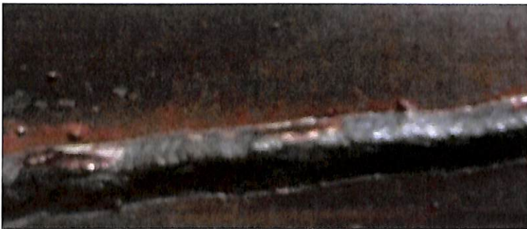
รูปที่ 4.29 รอยเชื่อมของการติดตั้ง DC Choke
