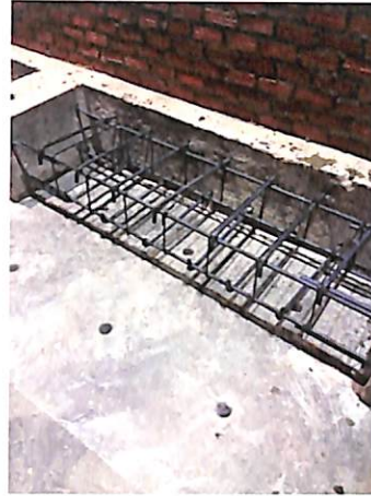
ประกอบเหล็กเสริมฐานโครงข้อแข็ง
