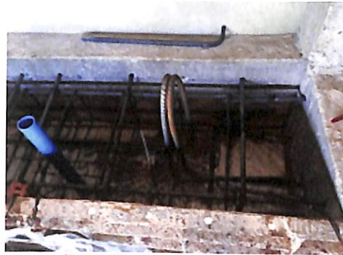
ตั้งแบบเหล็กฐานพร้อมเทคอนกรีต
