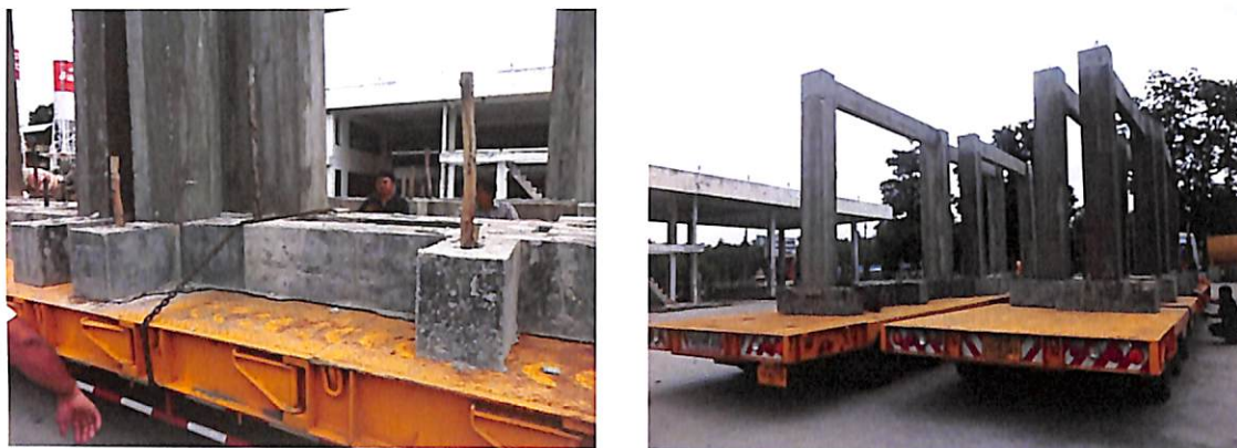
รูปที่ 4.21 ขั้นตอนการเคลื่อนย้ายโครงข้อแข็งคอนกรีตเสริมเหล็ก
