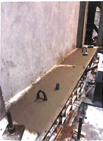
เทคอนกรีตเสริมฐานโครงข้อแข็ง
