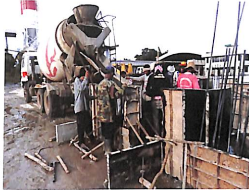
รูปที่ 4.13 เทคอนกรีตทำฐานโครงสร้างข้อแข็งคอนกรีตเสริมเหล็ก
