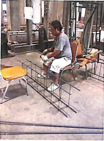
ผูกเหล็กเสริมฐานโครงข้อแข็ง
