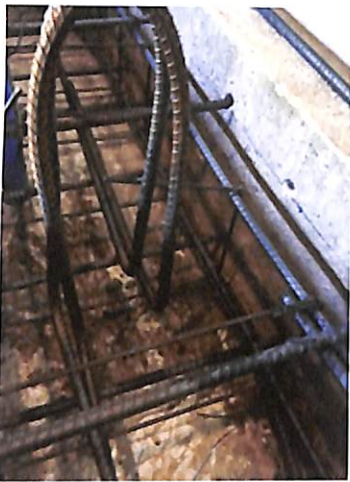
ติดตั้งตำแหน่งเหล็กยกฐานโครงข้อแข็ง
