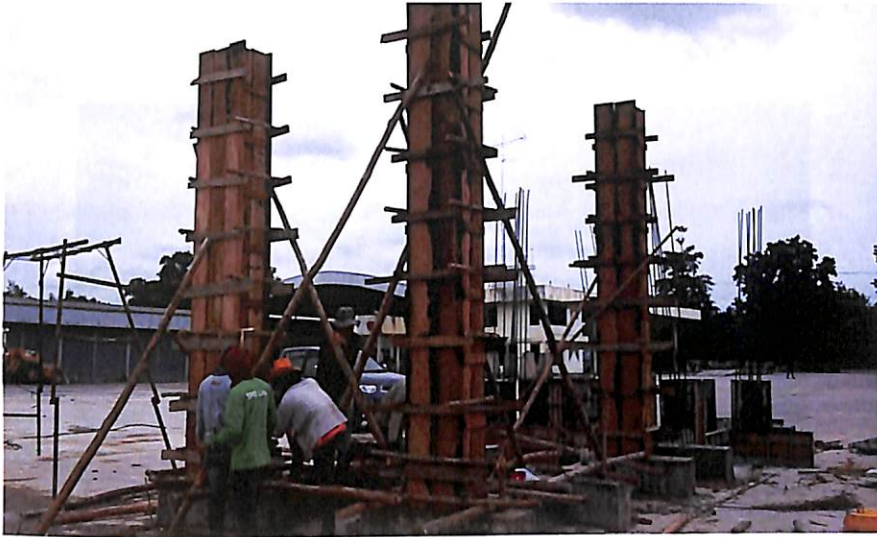
รูปที่ 4.16 ตั้งแบบเสาโครงข้อแข็งคอนกรีตเสริมเหล็ก
