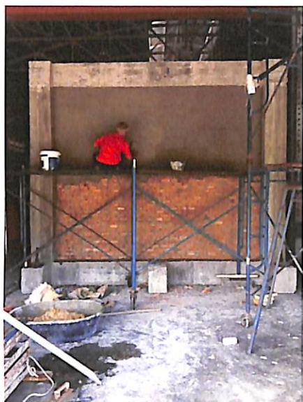
รูปที่ 4.26 ผนังอิฐก่อที่ทำการฉาบในโครงข้อแข็งคอนกรีตเสริมเหล็ก
