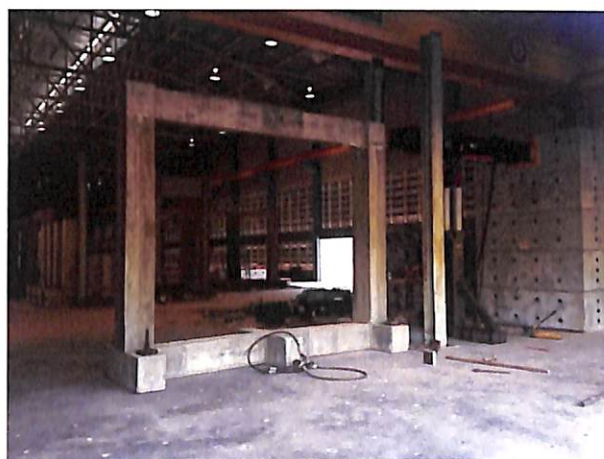
รูปที่ 4.22 เคลื่อนย้ายโครงข้อแข็งคอนกรีตเสริมเหล็กเข้าตำแหน่งทดสอบ
