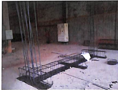
รูปที่ 4.11 การผูกเหล็กเสาโครงข้อแข็ง
