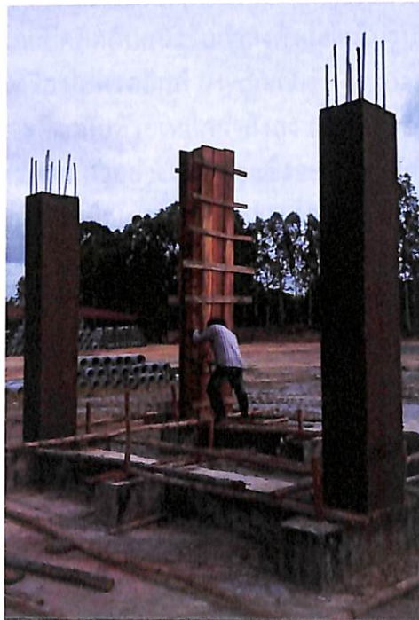
รูปที่ 4.17 เสาโครงข้อแข็งคอนกรีตเสริมเหล็ก
