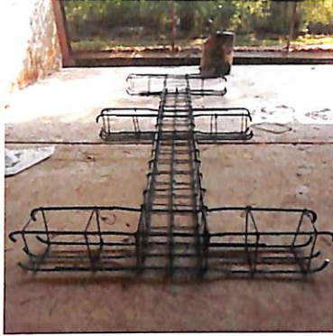
รูปที่ 4.10 การผูกเหล็กเสริมฐานโครงข้อแข็ง
