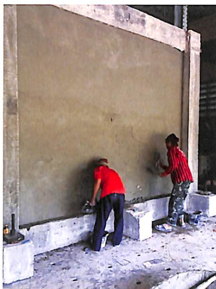
รูปที่ 4.26 ผนังอิฐก่อที่ทำการฉาบในโครงข้อแข็งคอนกรีตเสริมเหล็ก
