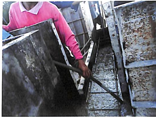
รูปที่ 4.14 การจี้เขย่าในคอนกรีตฐานโครงสร้างข้อแข็งคอนกรีตเสริมเหล็ก
